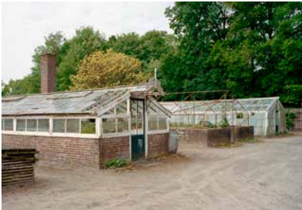
Almelo, buitenplaats Bellinckhof, Wierdensestraat 206, verschillende kassen in de moestuin, foto IJ.Th. Heins 2003, no. 334.666 Collectie RCE. Van links naar rechts: houten tabletkas, vervallen ijzeren tabletkas en betonnen druivenkas.
