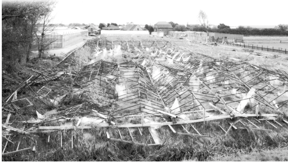
Heenweg, Maasdijk hoek Zijdijs, restanten van kassen, J.P. de Koning 1999, no. 327.808 Collectie RCE.
