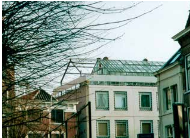
Leiden, Hooigracht 1 - 3, foto B.H.J.N. Kooij 2006, Collectie RCE. In de oude binnenstad is in 1996 een jongerenhuisvesting met op het dak een kas gerealiseerd. De nieuwbouw is door architect Fons Verheijen van bureau VVKH architecten uit Leiden ontworpen in opdracht van Stichting Studentenhuisvesting Leiden. De kas, type breedkap, neemt ongeveer 2/3 deel van het dak in beslag. Zo blijft er nog een gedeelte over voor een dakterras. De kasruimte is een gemeenschappelijke ruimte die door een centrale trappartij wordt ontsloten. Het idee van een kas op het dak is niet nieuw want in het tijdschrift Onze Tuinen 1 juni 1907 worden al voorbeelden gegeven, ook zelfs van broeibakken.
