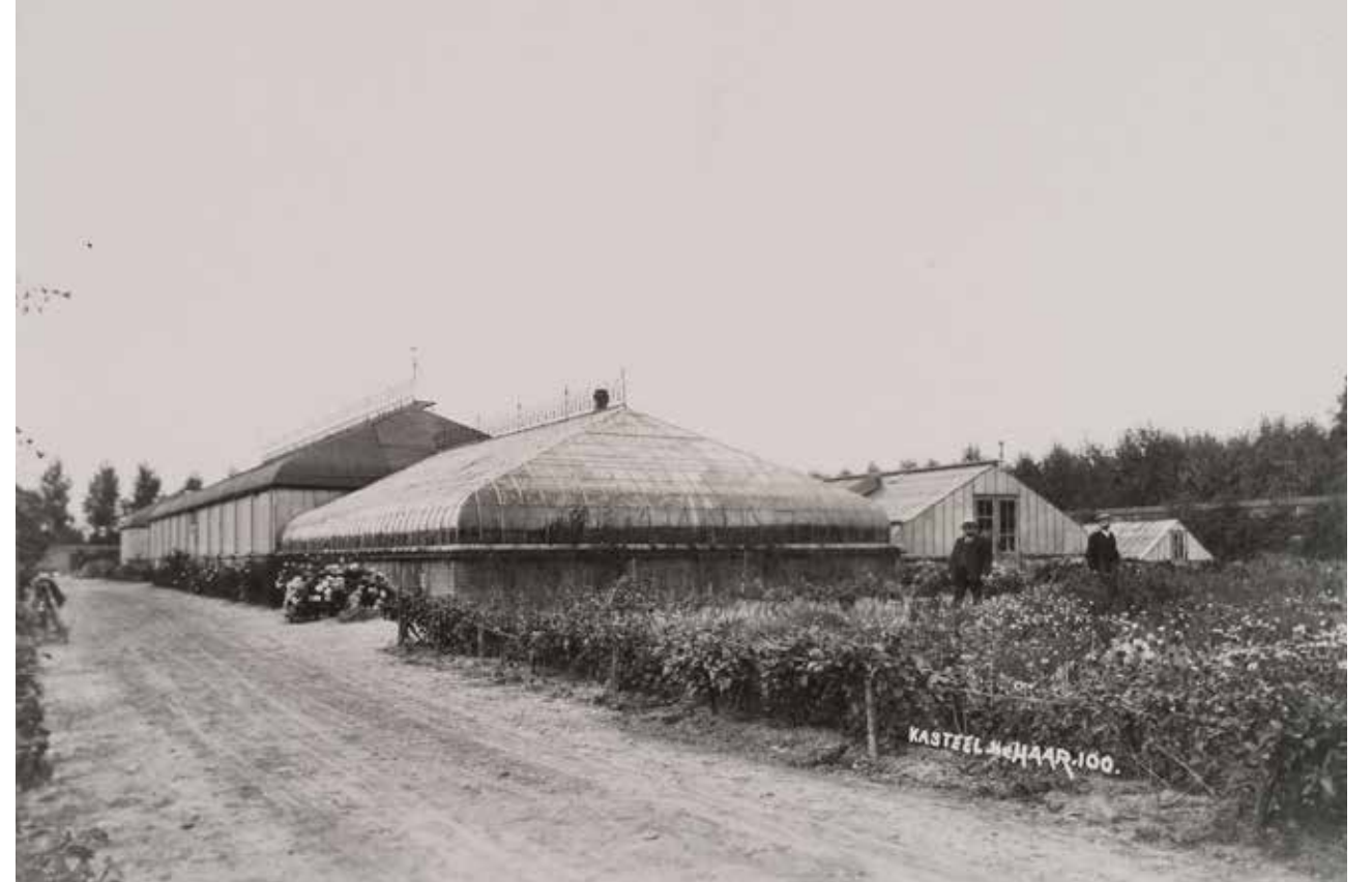
Haarzuilens, kasteel de Haar, overzichtsfoto van de kassen, foto E.A. van Blitz & Zoon Utrecht ca. 1910, no. 506.724 Collectie RCE. Van links naar rechts drie ijzeren kassen: de tropische kas (wintertuin), de bloemenkas (brede tabletkas) en de kweekkas (smalle tabletkas). In het midden staat tuinbaas Lambert Voortman, die hier in 1898 in dienst kwam.
