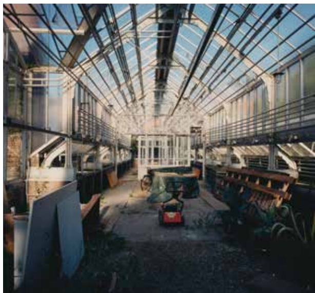
Utrecht, Oude Hortus Botanicus, foto uit 1999 van het interieur van een van de compartimenten in de collectiekas (1907) vóór de restauratie, Collectie RCE.
