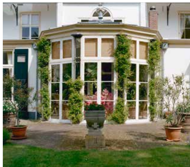
Oegstgeest, Rhijngeest, foto van de wintertuin; in de vloer waren plantenbakken verzonken en tegen de wanden was een treillage aangebracht. Buiten zat latwerk voor plantenklammers. Foto IJ.Th. Heins 2003, no. 346.172 Collectie RCE.
