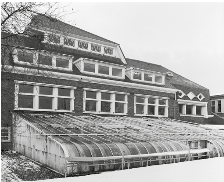
Wageningen, Generaal Foulkesweg 70-72, Schip van Blaauw, overzichtsfoto van de achtergevel met muurkas, foto A.H.C. Schollen 1981, no. 222.231, Collectie RCE.
