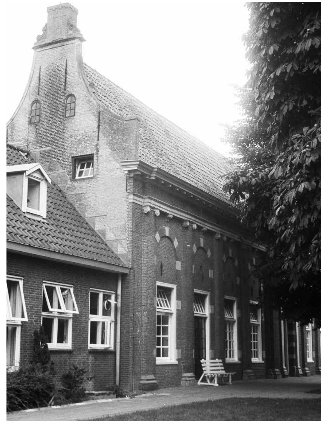
Franeker, voormalige Academie, overzicht van de oranjerie uit 1650, foto T.H. de Haan 1968, no. 119.293 Collectie RCE.
