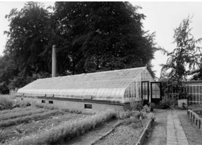
De Bilt, Buitenplaats Vollenhoven, ijzeren tabletkas met schoorsteen, A.J. van der Wal 1998, no. 354.363 Collectie RCE. Met plattegrond. Buitenwerkse afmetingen van 7,30 x 20,16 m, tekening B.H.J.N. Kooij 2006, naar tekening van architect D. Bak Edam 1994, Collectie RCE.
