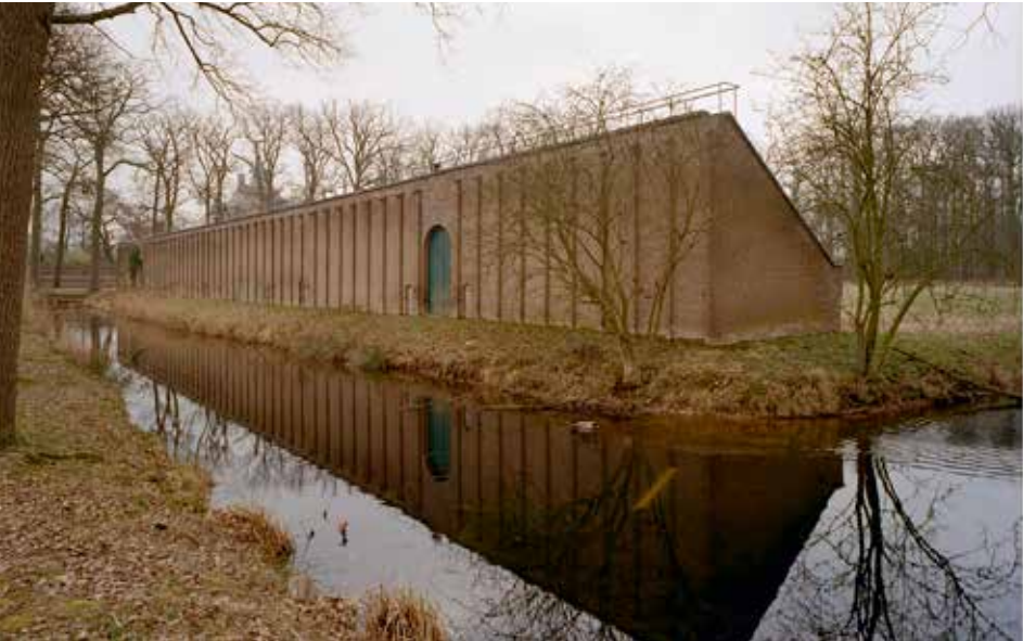
Heeswijk, kasteel Heeswijk, overzicht achterzijde muurkas, foto IJ.Th. Heins 2003, no. 356.972 Collectie RCE.
