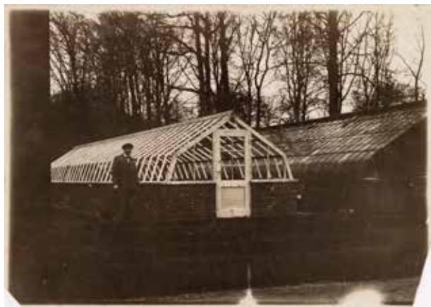
Neerijnen, kasteel Neerijnen, foto van de kasteeltuinen met twee kassen, Collectie D.M. Servaas te Zeist, repro no. 505.845 Collectie RCE. De rechter ijzeren tabletkas is door de firma Gadellaa uit Zeist gebouwd. De kas is inmiddels gerestaureerd. Van de houten tabletkas voor bloementeel links op de foto bestaat alleen nog de bakstenen onderbouw.
