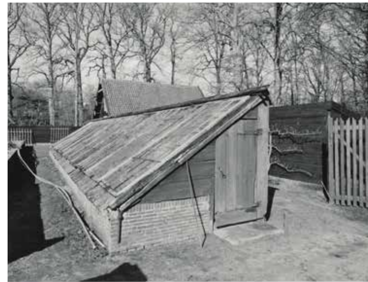
's-Graveland, buitenplaats Jagtlust, exterieur houten lessenaar in moestuin, vóór de restauratie, G.J. Dukker 1995, Collectie RCE. Met tekening van de dwarsdoorsnede over de houten muurkas (XIX a), opmeting en tekening B.H.J.N. Kooij, Zeist 2003, archief RCE. De kas telt 12 kasramen van 1,25 x 2,75 m; elk raam heeft in de breedte vier ruitjes.
