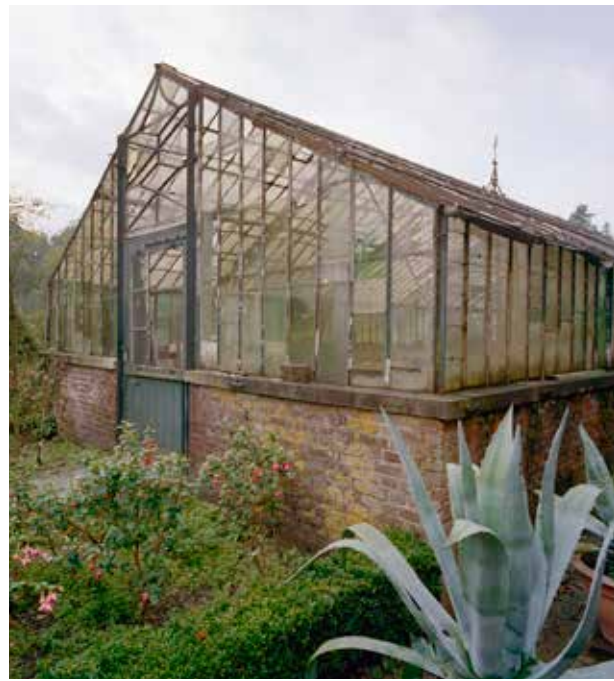
Geldrop, kasteeltuon, entree tabletkas (ca. 1885), foto J.P. de Koning 2001, no. 338.822 Collectie RCE. In het archief van de RCE bevindt zich tevens een opmeting van deze kas uit 2000.
