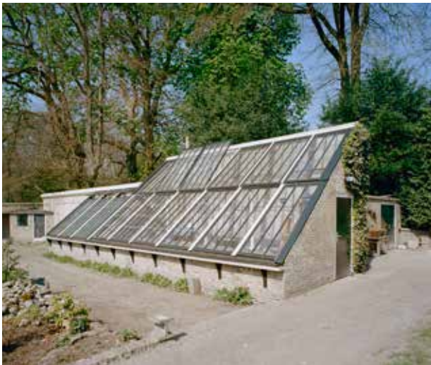
Heerenveen, buitenplaats Oranjewoud, exterieur muurkas in de overtuin, foto IJ.Th. Heins 2003, no. 346.239 Collectie RCE.
