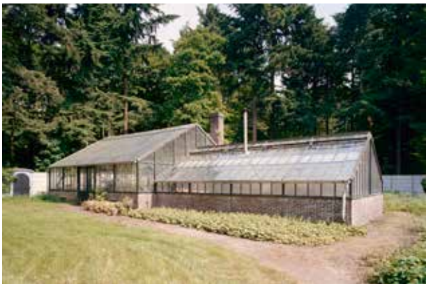
Laren (N-H), Larenberg, overzicht kas in de moestuin; het rechter lagere deel is een tabletkas die diende als zaai- en stekkas, het grotere linker deel is een fruitkas, in het midden is de schoorsteen van de verwarming nog net zichtbaar, foto IJ.Th. Heins 2003, no. 346.729 Collectie RCE.
