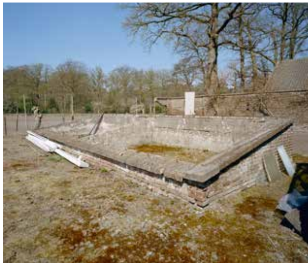
Maartensdijk, Eyckenstein, gemetselde koude bak met twee compartimenten, foto IJ.Th. Heins 2003, no. 341.362 Collectie RCE.
