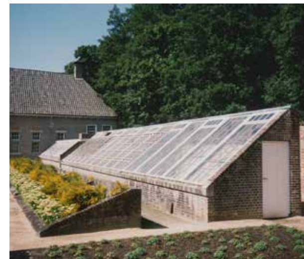
Wijhe, Havezathe 't Nijenhuis, gerestaureerde muurkas met daarvoor een koude bak, foto B.H.J.N. Kooij 2001, Collectie RCE.
