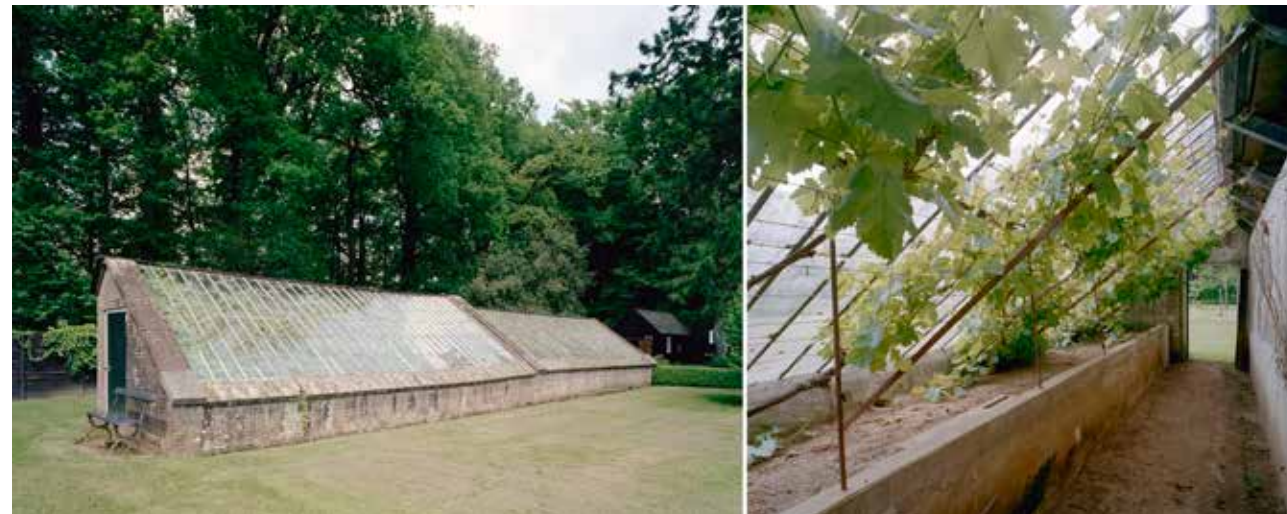
Dalfsen, Hoonhorst, De Horte, kopkas met twee compartimenten, in gebruik als druivenkas; rechts het interieur. Foto's IJ.Th. Heins 2003, no. 346.721 en 346.727 Collectie RCE.
