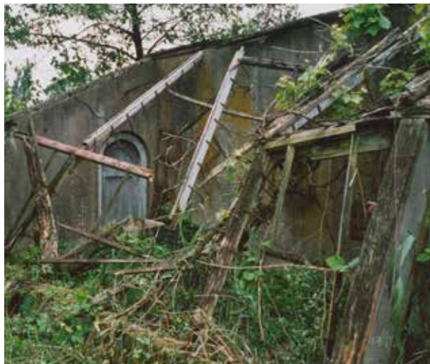
Nieuwersluis, buitenplaats Middenhoek, deel van de voorzijde van de muurkas, type gebroken lessenaar, foto B.H.J.N. Kooij 2005, Collectie RCE.
