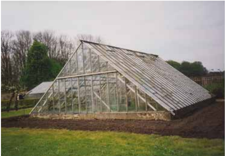
Breukelen, buitenplaats Queekhoven, een zogenoemde houten A-kas in de moestuin, foto B.H.J.N. Kooij 1999, Collectie RCE. Met plattegrond, voorgevel (noordgevel), doorsnede en details, tekening B.H.J.N. Kooij 2005, naar tekening van architect D. Bak, Edam 1999. Details: 1. glasroede; 2. hoekstijl ter plaatse van aansluiting dak en kopgevel; 3. nokbalkversiering. De glassponningen van de hoekstijlen zijn 12 x 12 mm en van de roeden 12 x 16 mm. Plattegrond ca. 9 x 11 m. Muurplaat 6 x 15,5 cm. Draagconstructie: ijzerconstructie van gebogen spanten en gordingen van ca. 60 mm.
