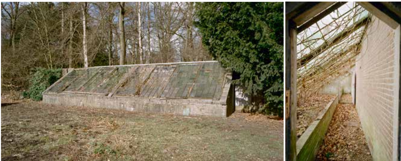
Doorn, La Forêt, muurkas in de moestuin, met rechts het interieur met in het midden de tussenwand, foto J.P. de Koning 2002, no. 342.178 en 342.208 Collectie RCE.
