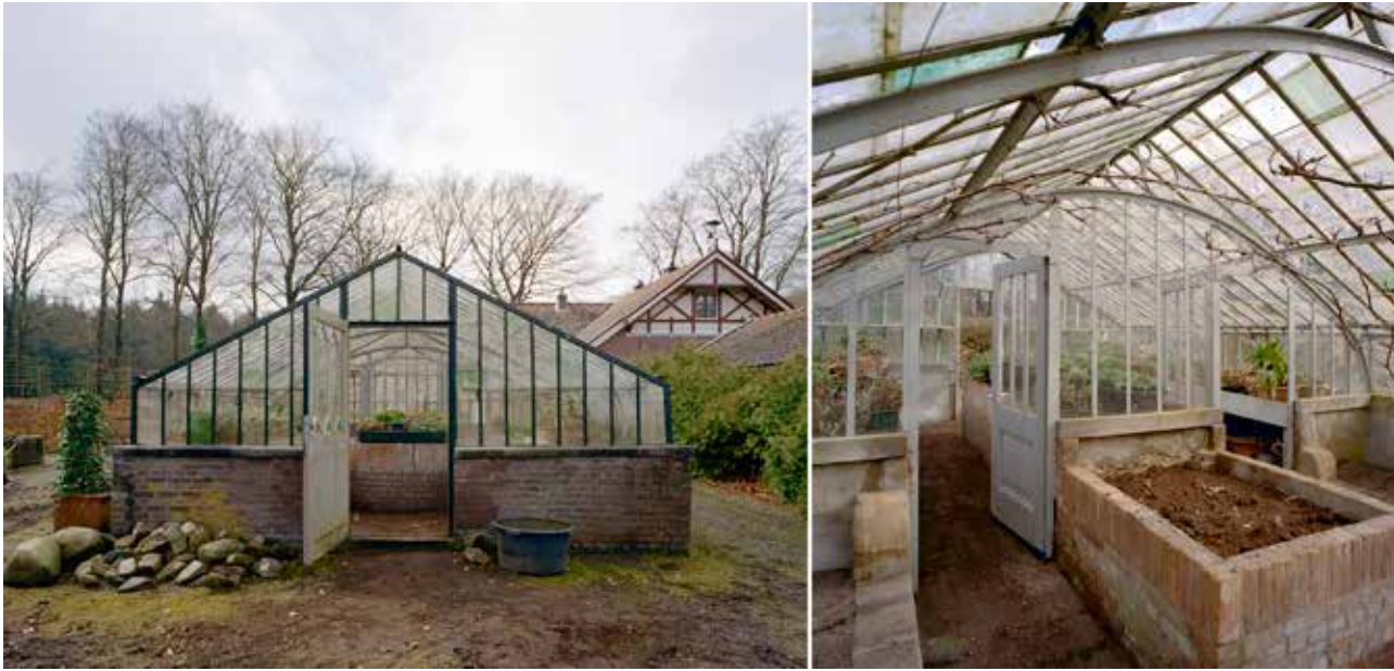
Rhenen, Prattenburg, interieur en exterieur tabletkas, foto J.P. de Koning 2002, no. 342.351 en 342.353 Collectie RCE.
