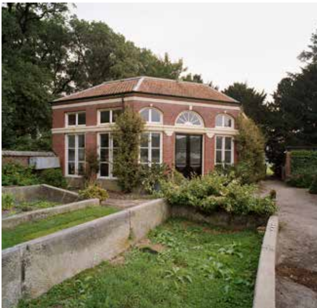
Markelo, kasteel Weldam, oranjerie in moestuin met op de voorgrond natuurstenen bakken, foto IJ.Th. Heins 2005, no. 513.751 Collectie RCE.
