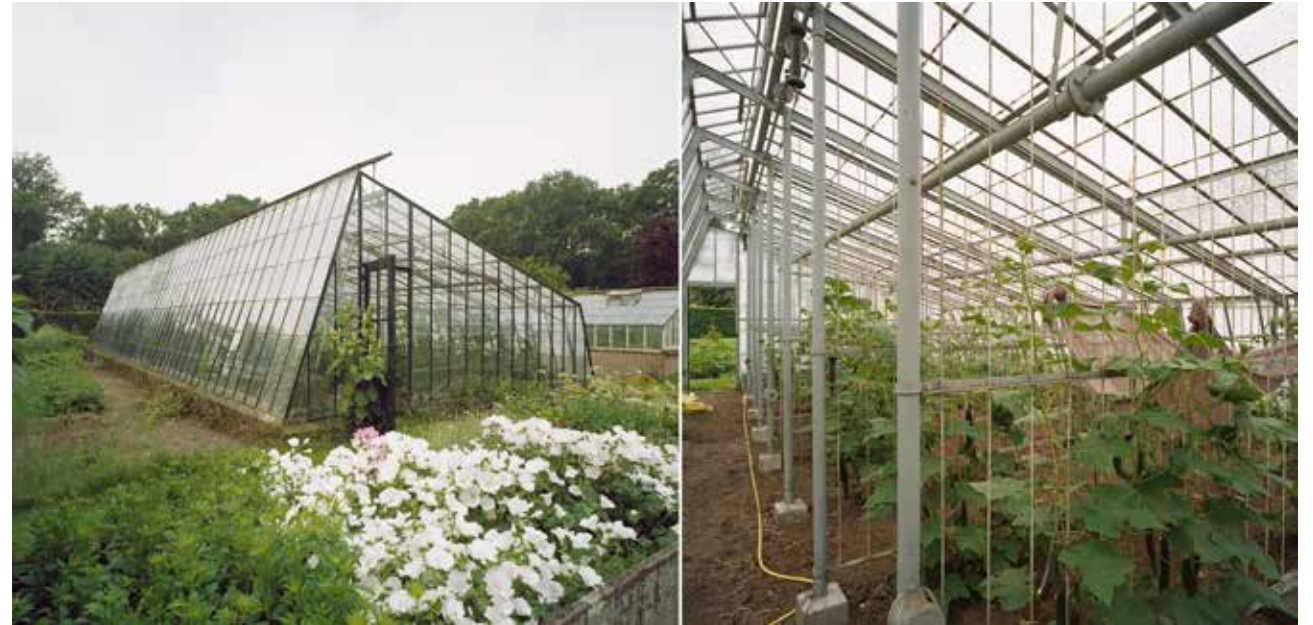
Heeten, buitenplaats Schoonheten, exterieur en interieur ijzeren asymmetrische kas in de moestuin, foto IJ.Th. Heins 2005, no. 513.711 en 513.715 Collectie RCE.
