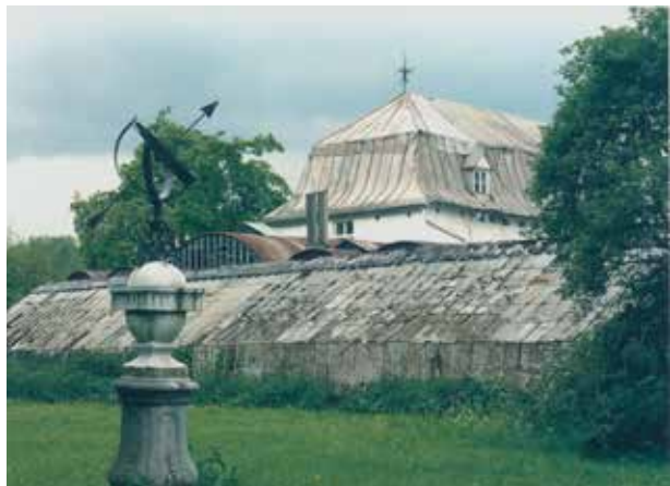
Maastricht, kasteel Vaeshartelt, verdwenen muurkas, foto P. van Galen 1991, no. 290.537 Collectie RCE.
