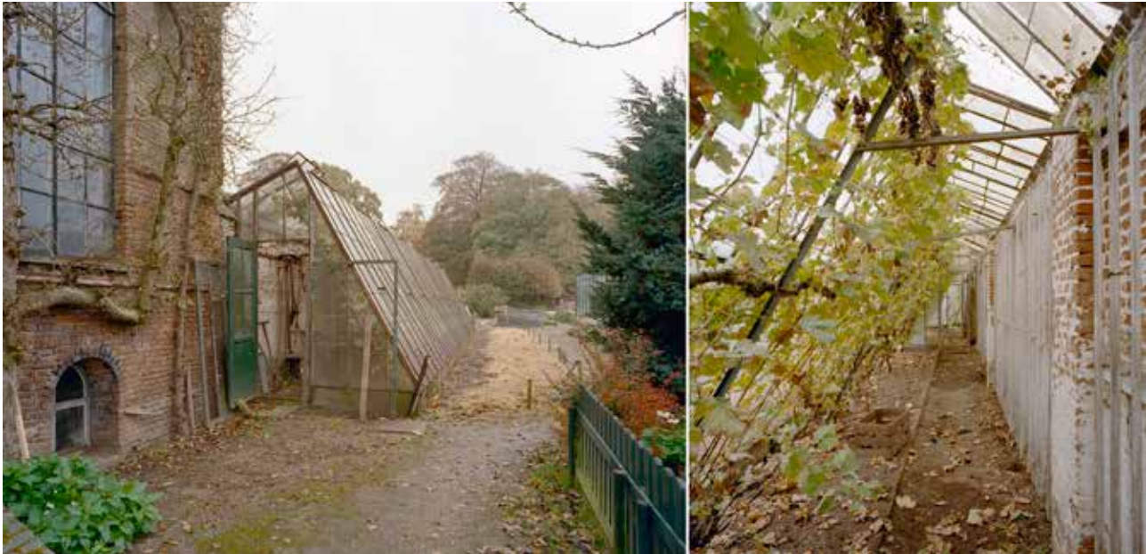
Beesd, Mariënwaerd, ijzeren kopkas gebouwd tegen oude fruitmuur in de moestuin met op de voorgrond links de oude oranjerie. Rechts het interieur met op de voorgrond rechts de oude spalieren voor het opbinden van het leifruit. Foto's J.P. de Koning 2001, no. 338.793 en 338.812 Collectie RCE.
