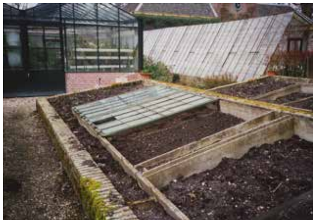
Beesd, buitenplaats Mariënwaerd, gemetselde grondbak en betonnen binnenbak, foto B.H.J.N. Kooij 2000, Collectie RCE.
