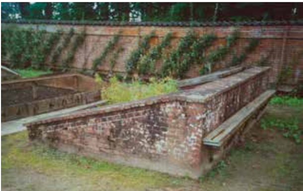
Dalfsen, buitenplaats de Aalshorst, voorzijde en achterzijde verdiepte kasbak, foto B.H.J.N. Kooij 2002, Collectie RCE.
