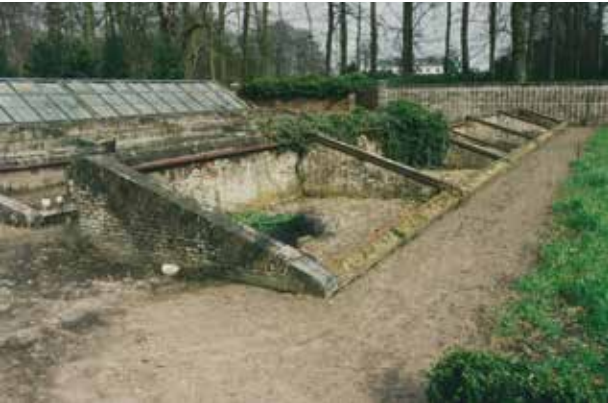
De Bilt, buitenplaats Vollenhoven, oorspronkelijk verwarmde gemetselde bakken, foto B.H.J.N. Kooij 2002, Collectie RCE.
