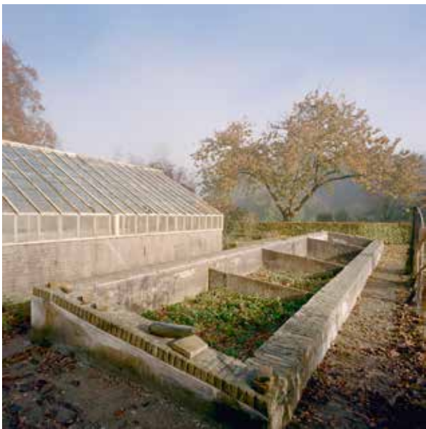
Empe, huis Empe, gemetselde koude bakken met vier compartimenten, foto J.P. de Koning, 2001, no. 338.769 Collectie RCE.
