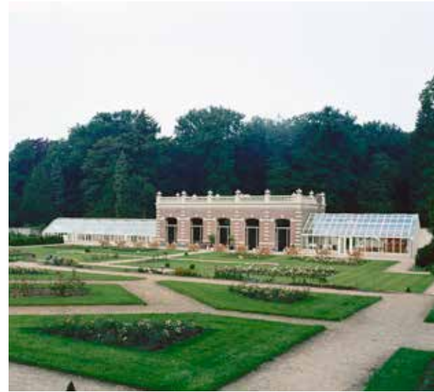
Arnhem, Warnsborn, gerestaureerde oranje-rie met de twee nieuw gebouwde serres ten behoeve van de horecafunctie met op de voorgrond de gerestaureerde tuin van H. Copijn, foto J.P. de Koning 2002, no. 344.894 Collectie RCE.
