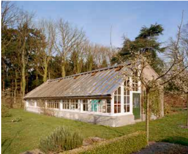
Hattem, Huis Molecaten, oranjeriekas vóór en na de restauratie. Op het dak lagen eerst golfplaten; na de restauratie ligt er glas. Foto's A.J. van der Wal 1992, no. 292.911 en IJ.Th. Heins 2002, no. 342.410 Collectie RCE.
