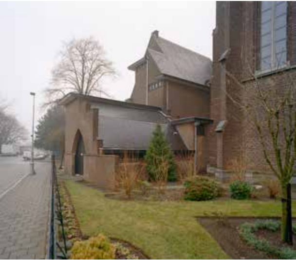
Maastricht, St.-Martinuskerk, oranjeriekas verbouwd tot garage, foto IJ.Th. Heins 2001, no. 335.651 Collectie RCE.
