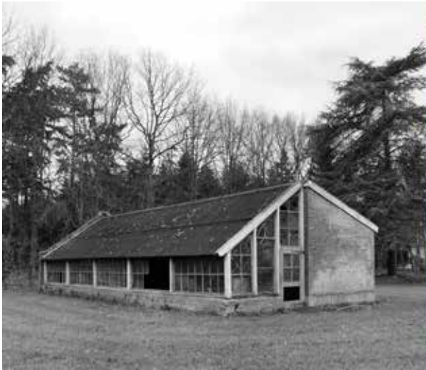
Hattem, Huis Molecaten, oranjeriekas vóór en na de restauratie. Op het dak lagen eerst golfplaten; na de restauratie ligt er glas. Foto's A.J. van der Wal 1992, no. 292.911 en IJ.Th. Heins 2002, no. 342.410 Collectie RCE.
