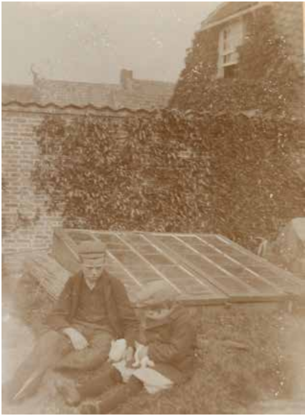
Monster, foto uit ca. 1900 van karakteristieke broeiramen zoals die in de glastuinbouw werden gebruikt, later stapte men over op de éénruiters, foto uit het archief van het voormalige Proefstation te Naaldwijk. Broeiramen worden in het Westland ook wel als schietramen aangeduid.
