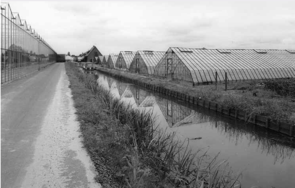
Heenweg, adres: Heenweg, karakteristieke Westlandse druivenkassen die in de twintigerjaren van de vorige eeuw zijn gebouwd, foto J.P. de Koning 1999, no. 327.813 Collectie RCE.
