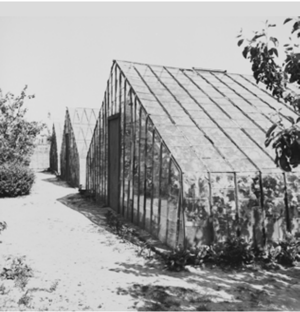
Foto uit het begin van de twintigste eeuw van druivenserres van het oude model waarvan de zijwanden nog vrij steil waren gebouwd, wat minder gunstig bleek voor de opbrengst, no 2147 archief van het voormalige Proefstation te Naaldwijk.
