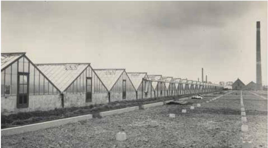
Het Westland, blokkassen op stenen onderbouw voor komkommerteelt, maker en datering foto onbekend (ca. 1930), Collectie RCE. Op de voorgrond is de fundering van een warenhuis geplaatst.
