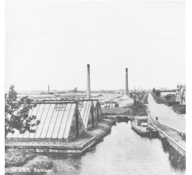
De Lier, Kerklaan, twee houten A-kassen met de beluchtingsramen open, foto uit archief van het Westlands Museum in Honselersdijk, no. 502-1-2.
