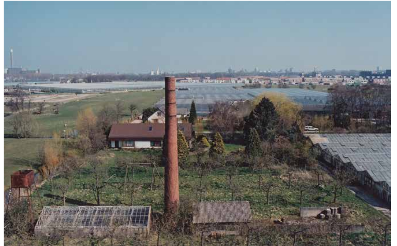
Vleuten, Johanniterweg 8, Schoorsteen gebouwd in 1927 en unieke ijzeren watertoren op de tuinderij van Klein van Willigen, zeppelifoto no. 2903020748 Hi-shots 2001.
