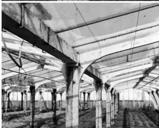
Vleuten, Alendorperweg 15, detail voorzijde en deel interieur met het jaartal 1951 van het betonnen warenhuis van Boerie Jongerius, foto J.P. de Koning 1999, no. 331.381 en 331.386 Collectie RCE. Oorspronkelijk was het kassencomplex afgedekt met éénruiters, maar later zijn zij vervangen door vaste roeden.
