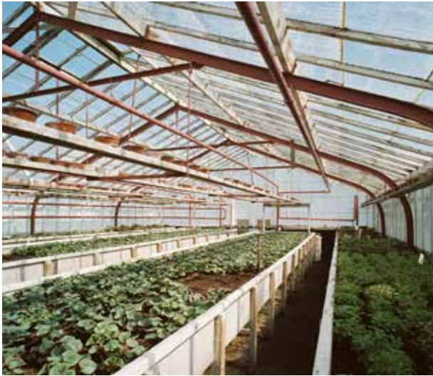
Aalsmeer, interieur potplantenkas (spantenkas) in de Historische Tuin Aalsmeer, foto IJ.Th. Heins 2005, no. 513.928 Collectie RCE.
