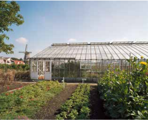
Aalsmeer, de spantenkas gebouwd in 1960 door CTAV is in gebruik als rozenkas bij de Historische Tuin Aalsmeer, foto IJ. Th. Heins 2005, no. 513.950 Collectie RCE.
