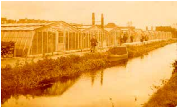
Brede warenhuizen gedekt met dubbele rijen éénruiters, Collectie Stichting Oud Loosduinen. Het warenhuis was een grote verbetering ten opzichte van het platglas. In het warenhuis konden hoogopgaande gewassen (o.a. tomaat) worden geteeld. Het werk werd gedaan onder glas. Bij platglas moest het werk in weer en wind (buiten) worden gedaan. De sloten waren vóór de Tweede Wereldoorlog belangrijk voor de afvoer van producten.
