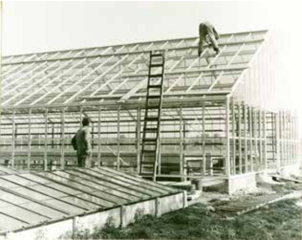
Aalsmeer, bouw van nieuwe breedkapkas (spantenkas), foto ca. 1960, Collectie Historische Tuin Aalsmeer.
