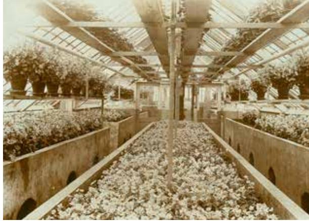
Aalsmeer, kas met begonia's bij kwekerij D. Baardse, foto 1910, Collectie H. Alderden, Aalsmeer. In de kas zijn betonnen rabatten geplaatst.
