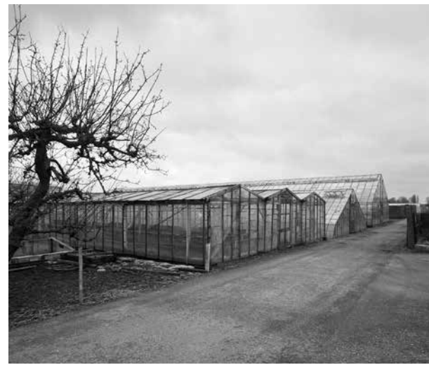
Vleuten, Utrechtseweg 13-15, kassen direct achter de woning van Utrechtseweg 13, foto J.P. de Koning 2001, no. 340.203 Collectie RCE. Van links naar rechts: een houten warenhuis, een Westlandse ijzeren druivenserre en een ijzeren breedkapkas.
