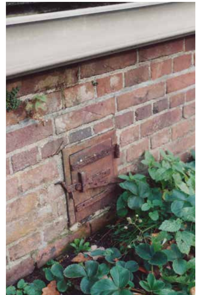
Cothen, kasteel Rhijnestein, ventilatieluikje in de onderbouw van de tabletkas, foto E. Geytenbeek 1999, Collectie RCE.
