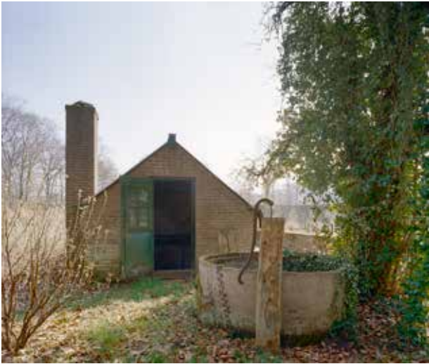
Eefde, buitenplaats Den Dam, moestuin, stookhok en schoorsteen gebouwd in het verlengde van de tabletkas, foto IJ.Th. Heins 2002, no. 342.337 Collectie RCE.
