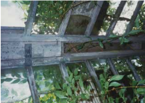
Dalfsen, Kasteel Rechteren, zeldzame ventilatieluiken die in de nok van de houten tabletkas zijn ondergebracht, foto B.H.J.N. Kooij 2002, Collectie RCE.
