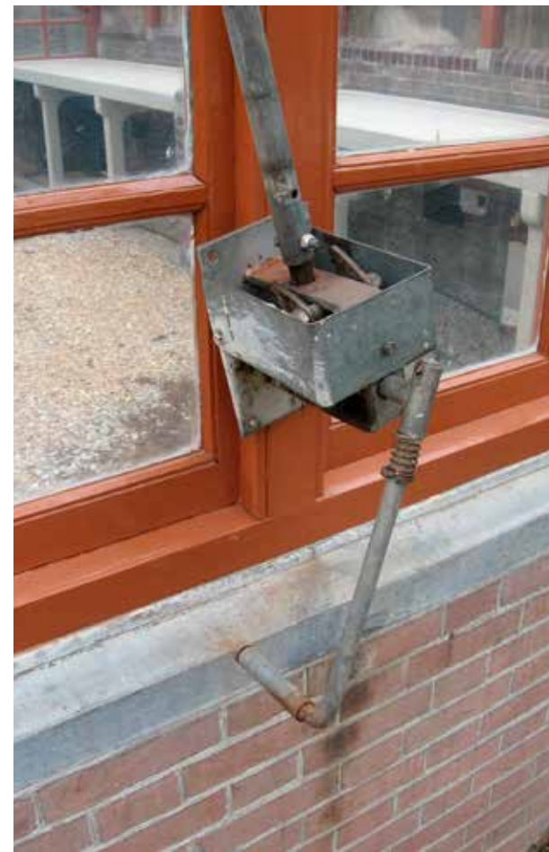
Utrecht, Oude Hortus Botanicus, mechaniek voor de bediening van de ventilatieramen, foto B.H.J.N. Kooij 2006, Collectie RCE.
