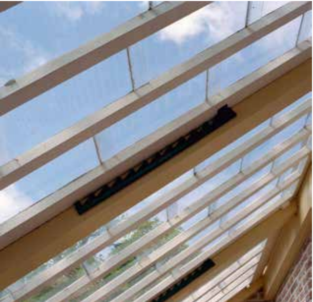
Oegstgeest, Rhijngeest, smeedijzeren tandstaaf ten behoeve van ventilatie van de muurkas, foto IJ.Th. Heins 2003, no. 346.179 Collectie RCE. Bij deze kas is het oude ventilatieprincipe nog aanwezig: de kasramen kunnen naar behoefte meer of minder open geschoven worden. Bediening geschiedt met de hand.
