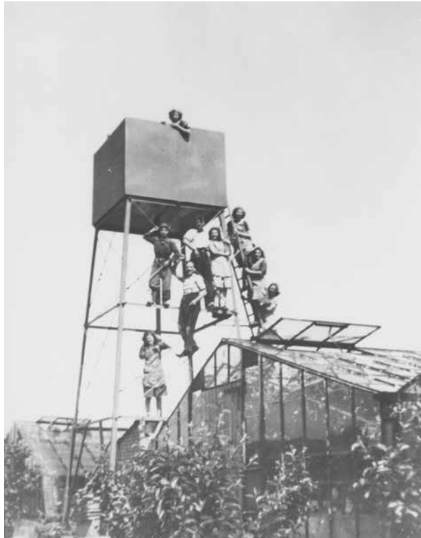
Ijzeren watertoren op een tuinderij in het Westland, datum onbekend, no. 344-4-13 Collectie Westlands Museum te Honselersdijk.
