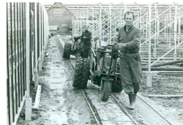
Het vervoer van kisten glas, van de vrachtauto of trein naar de plek in de kas waar het verwerkt moest worden, geschiedde met deze 'driewielers', Historisch Beeldarchief Glaverbel Nederland B.V. In de grond is de rails van het smalspoor goed te zien.
