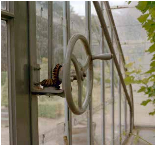
Ermelo, Oud-Groevenbeek, draaiwiel voor de bediening van de ventilatieramen in de druivenkas, foto J.P. de Koning 2001, no. 343.242 Collectie RCE. Dit is een luxe systeem dat alleen bij de duurdere exemplaren voorkomt.
