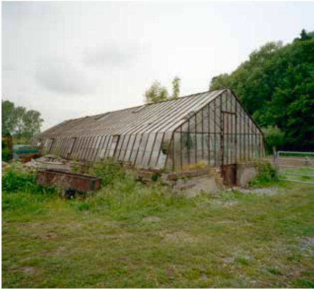
Eys, kasteel Goedenraad, ijzeren kas met ventilatieraampjes onder- en bovenin het dek, foto IJ.Th. Heins 2002 no. 356.949 Collectie RCE.
