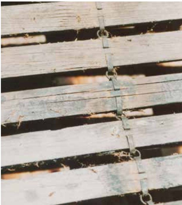
Lage-Vuursche, Biltseweg 4, buitenplaats Pijnenburg, detail schermmatten, foto E. Geytenbeek 2002, Collectie RCE.
