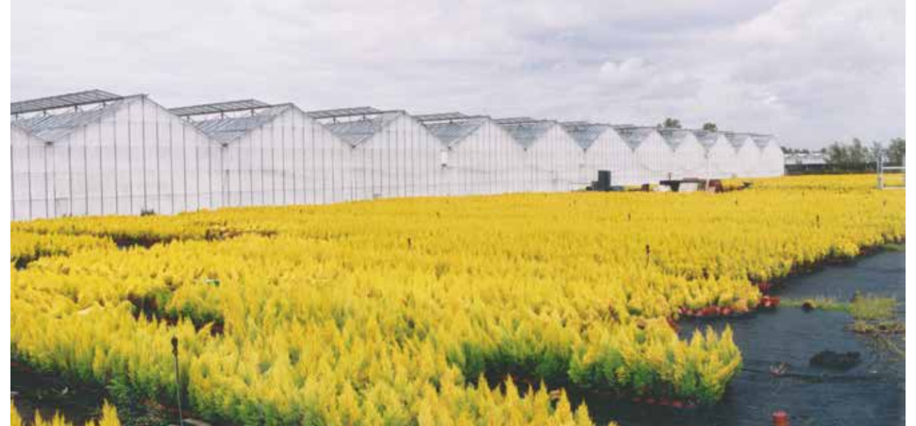
Poeldijk, modern kassencomplex met een doorgaande nokbeluchting, foto B.H.J.N. Kooij 2004, Collectie RCE.
