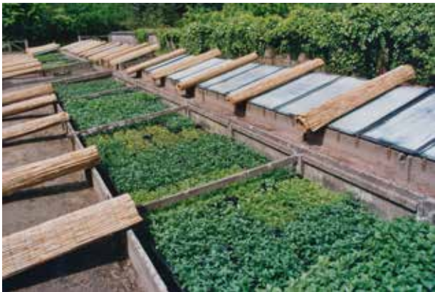
Apeldoorn, bloemisterij van Paleis Het Loo, rietmatten op de éénruiters van de betonnen bakken, foto B.H.J.N. Kooij 2004, Collectie RCE. De éénruiters zijn hier als een vorm van zonwering wit gekalkt. De rietmatten kunnen zowel voor het dekken als het schermen gebruikt worden.
