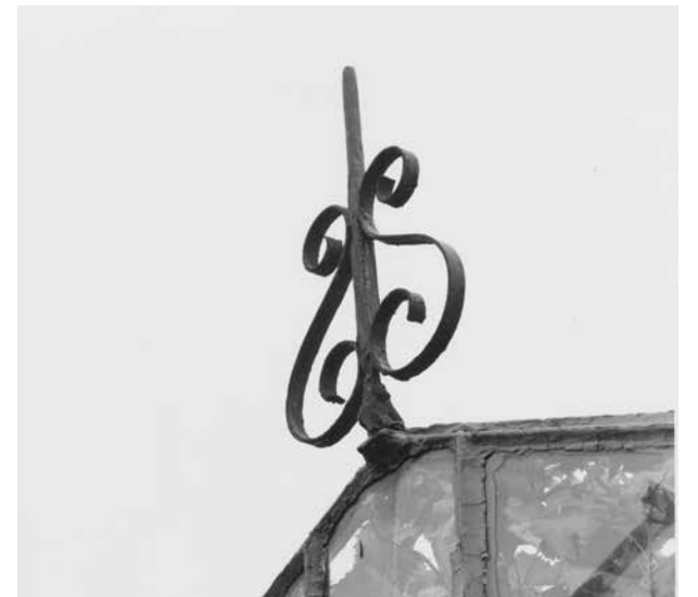
Monster, bij Assendelftlaan 8/9, druivenkwekerij Van Paassen, makelaar op een van de kassen, gemaakt kort vóór de sloop in 1999, foto G.J. Dukker 1999, no. 329.703 Collectie RCE.
