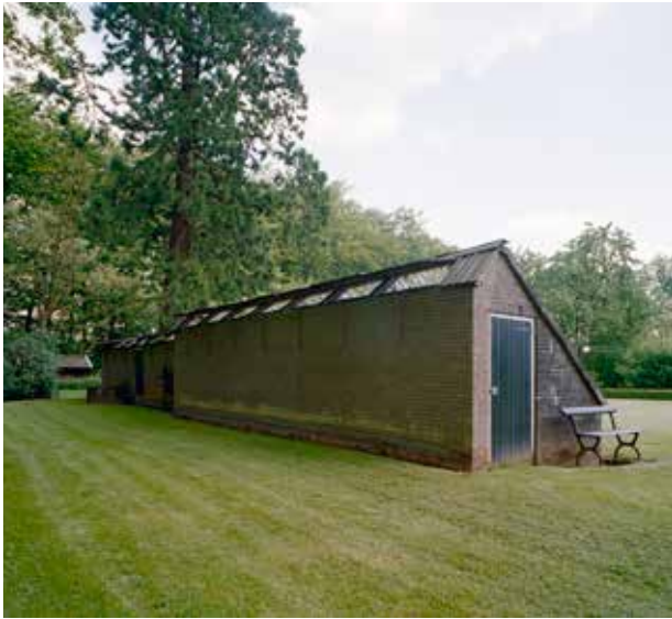
Dalfsen, Hoonhorst, De Horte, beluchttingsluiken aan de achterzijde van de kopkas, foto IJ.Th. Heins 2003, no. 346.723 Collectie RCE.
