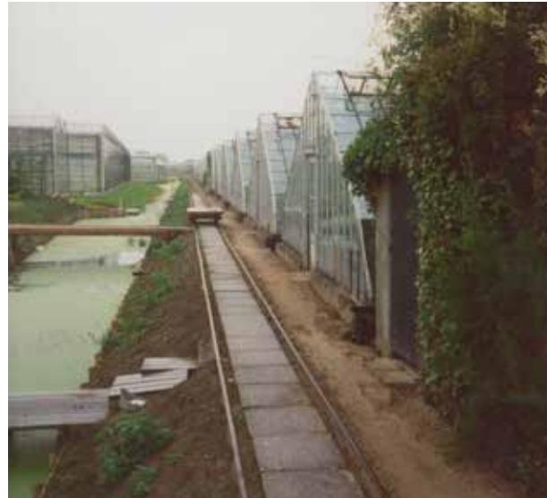
Naaldwijk, Zuidweg 39, smalspoor naast de kassen, foto B.H.J.N. Kooij 1999, Collectie RCE.
