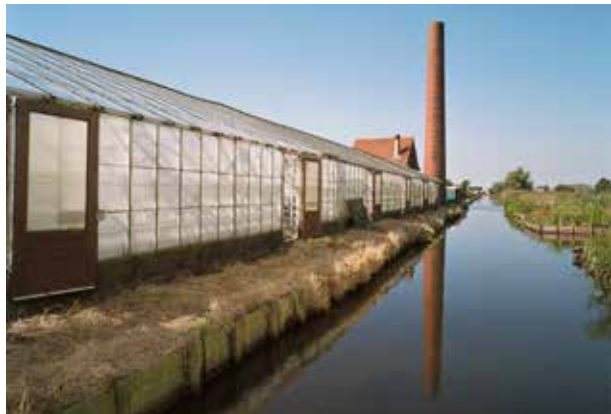
Aalsmeer, Uiterweg 50a, gemetselde schoorsteen op het bedrijf van Albert Maase, foto IJ.Th. Heins 2005, no. 513.982 Collectie RCE. Op de voorgrond van de trekheesterkwekerij zijn spantenkassen, type breedkapkassen te zien.
