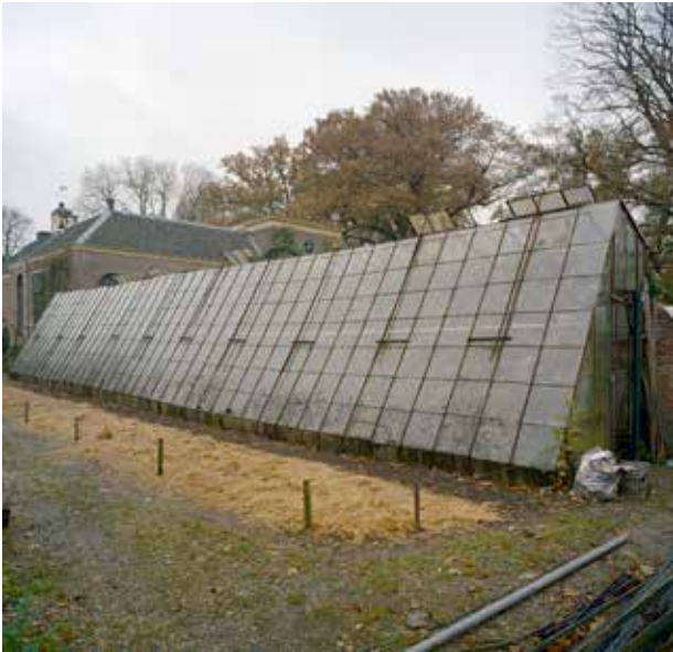
Beesd, Mariënwaardt, ijzeren kopkas gebouwd tegen oude fruitmuur in de moestuin met de openstaande ventilatieramen, links de oude oranjerie, foto J.P. de Koning 2001, no. 338.804 Collectie RCE. Bediening geschiedt met de hand.
