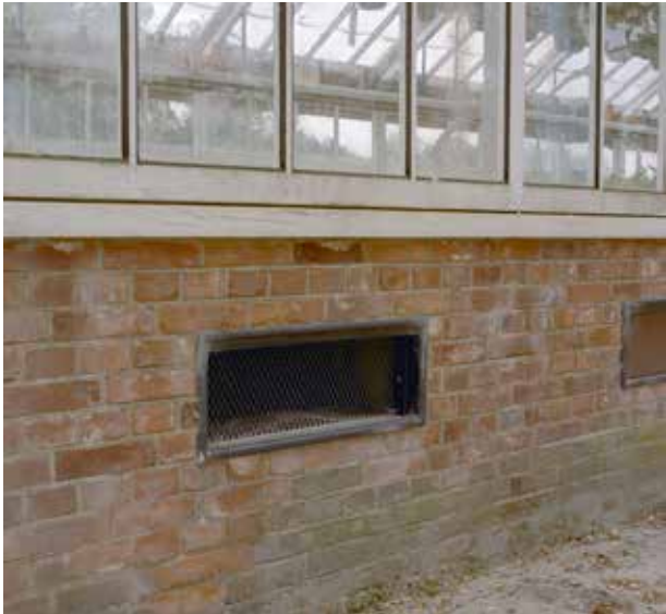
Ambt Delden, Kasteel Twickel, moestuin, ventilatierooster in de onderbouw van de houten anjerkas, foto IJ.Th. Heins 2002, no. 343.074 Collectie RCE.
