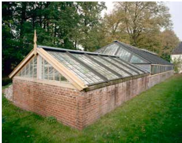
Slochteren, buitenplaats Fraeylemaborg, overzicht achterzijde vrijstaande kas, het lagere, kleinere gedeelte is de zaaikas, IJ.Th. Heins 2001, no. 311.927 Collectie RCE. Een dergelijke opstelling komt in Nederland weinig voor.
