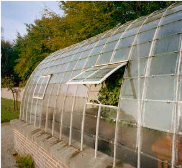
De Wijk, laag ventilatieraampje boogmuurkas, foto J.P. de Koning 2001, no. 338.660 Collectie RCE. De eenvoudigste vorm van een ventilatieraam in een vast dek. Bediening geschiedt met de hand.
