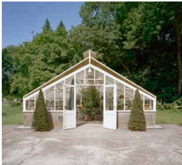
Terwolde, De Matanze, entree gerestaureerde tabletkas; zonwering wordt hier vanuit de nok neergelaten, foto A.J. van der Wal 2003, no. 312.442 Collectie RCE.
