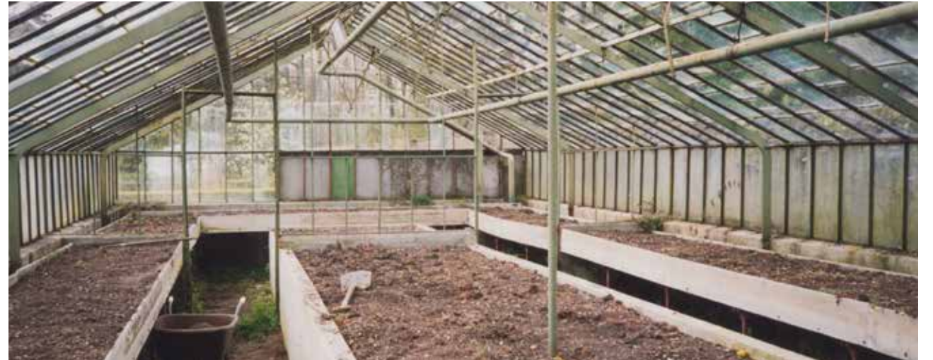
Breukelen, buitenplaats Queekhoven, interieur tabletkas met in het midden een kribbe en aan de buitenzijde tabletten, foto B.H.J.N. Kooij 1999, Collectie RCE. De ruimte onder de tabletten kan dienen voor de opslag van potjes en ander soortgelijk materiaal.
