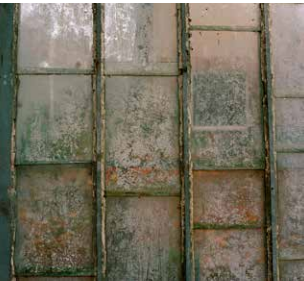
Meppel, stadskwekerij, gemetselde bak met broeiramen en een detail van één van de ramen, foto J.P. de Koning 2001, no. 338.628 en 338.630 Collectie RCE.
