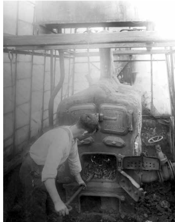
Kasstoker aan het werk bij de ketel, foto 1932, no. 2048-31 Spaarnestad Fotoarchief, Haarlem. In de begintijd van de glastuinbouw werden de kassen veel met kolen gestookt.
