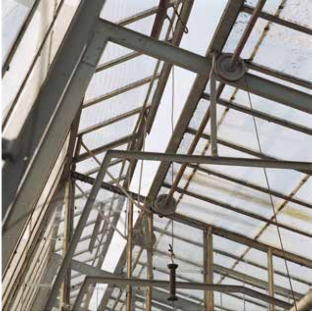
Schoonheeten, moestuin, detail interieur ijzeren zadelkas met ventilatieramen, foto IJ.Th. Heins 2005, no. 513.725 Collectie RCE.
