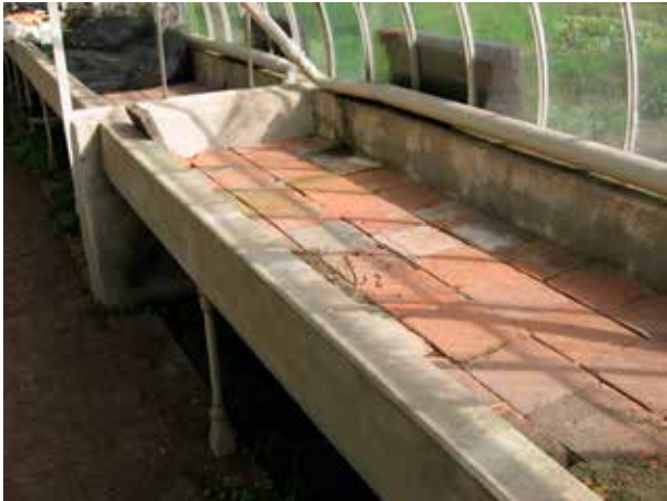
De Bilt, buitenplaats Vollenhoven, plavuizen als bodem in de tabletten in de ijzeren tabletkas, foto B.H.J.N. Kooij 2006.
