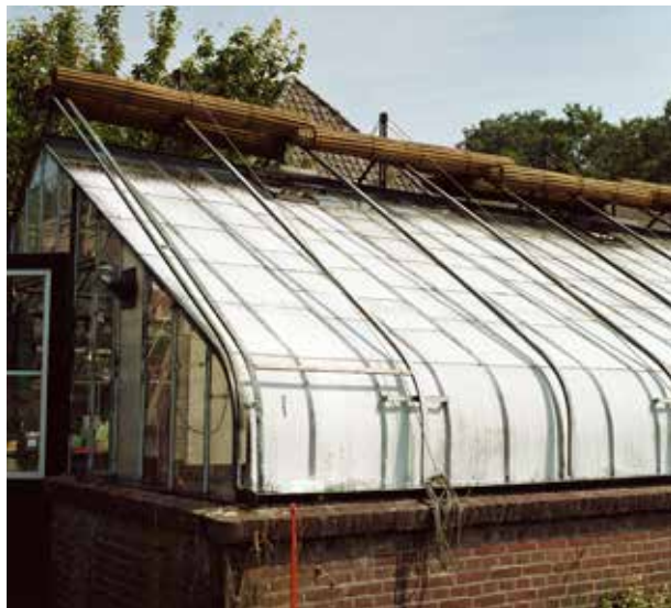
Schoonheten, buitenplaats Schoonheten, moestuin, detail tabletkas met zonwering, foto IJ.Th. Heins 2005, no. 513.732 Collectie RCE.
