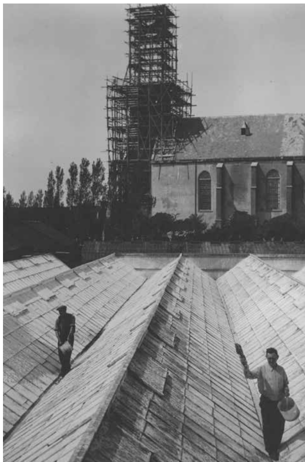
Den Haag, Willem III straat, het bespuiten van het glasdek met een verdunde kalkoplossing, foto 1941, Polygoonarchief 941.2455: ANP-archief Rijswijk: no. 0-82773 Haags Gemeentearchief. Op de achtergrond de Oude Kerk in restauratie. Bij gekrijt of gekalkt glas is de lichtopbrengst nog maar zo'n 50%.
