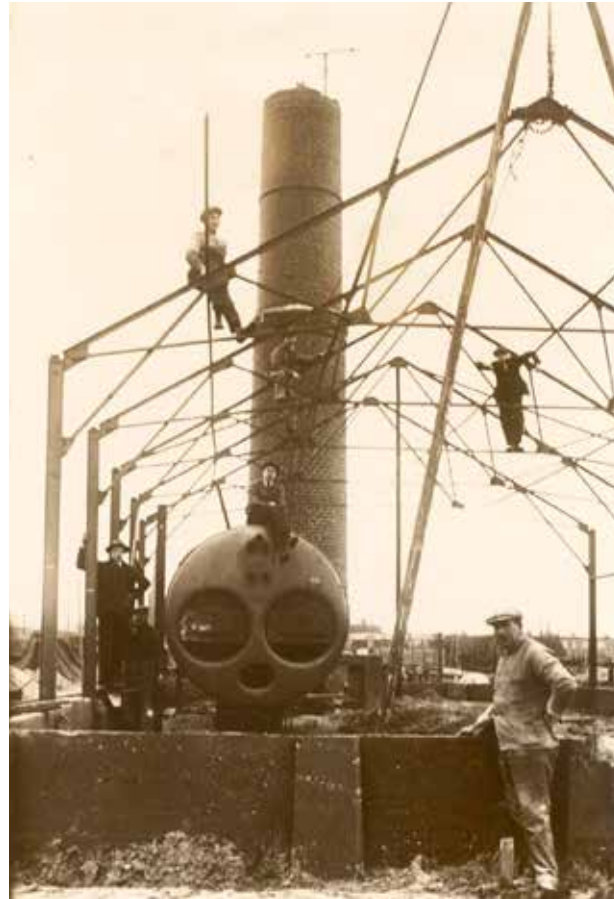
Loosduinen, foto van de bouw van het ketelhuis op de tuin van Jos Klinkenberg aan de Houtweg, Collectie Stichting Oud Loosduinen.
