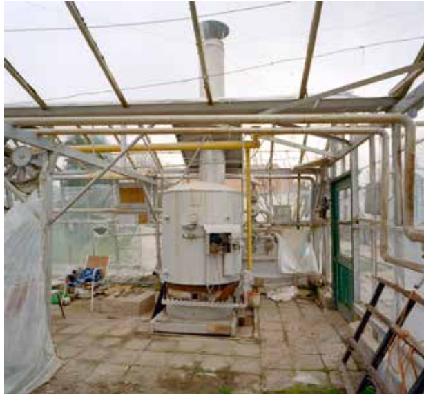
Huissen, Bloemstraat 12, naoorlogse ketels staan vrijwel altijd bovengronds. Met de invoering van de elektriciteit in de glastuinbouw zijn de stookketels vervangen door ketels met waterpompen die het plaatsen van de ketel in een verdiepte opstelling overbodig maakte, foto J.P. de Koning 2002, no. 342.154 Collectie RCE.
