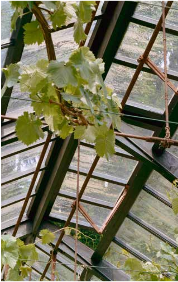
Laren (N-H), Larenberg, mechanisme voor de bediening van de ventilatieramen in de nok van de fruitkas, foto IJ.Th. Heins 20003, no. 346.742 Collectie RCE. De bediening geschiedt via een handel.
