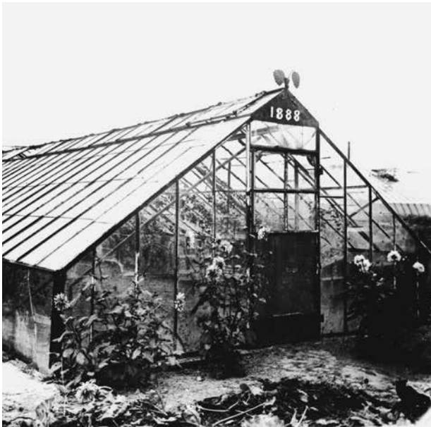
Poeldijk, tuin van Jan v.d. Knaap aan de Gantel, foto uit omstreeks 1900 van de eerste gebouwde vrijstaande ijzeren druivenkas in het Westland, gebouwd door smid Grimbergen uit Poeldijk in 1888, glasnegatief no. 2134 uit het archief van het voormalig Proefstation te Naaldwijk. Westlanders noemden hun druivenkassen druivenserres of druivenkasten.
