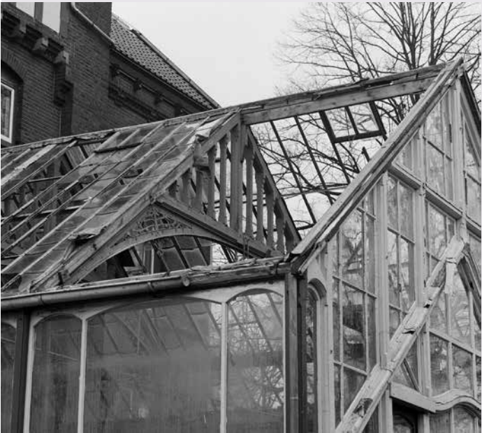
Steenwijk, villa Rams Woerthe, deel kap winter-tuin waarvan Braat de bijzondere spanten heeft geleverd, foto A.J. van der Wal 1974, no. 156.690 Collectie RCE.
