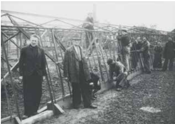
Poeldijk, foto van de bouw van een kas door medewerkers van de firma Th. Enthoven Kassenbouw van IJzer Torenzicht, opname gemaakt vóór de Tweede Wereldoorlog, no. 329-2-7 Westlands Museum in Honselersdijk De firmanaam "Torenzicht" van het bedrijf Th. Enthoven houdt verband met het jachtslot Torenzicht dat op het terrein van de heer Enthoven aan de Wateringseweg te Poeldijk stond en uiteindelijk rond 1912 werd gesloopt.
