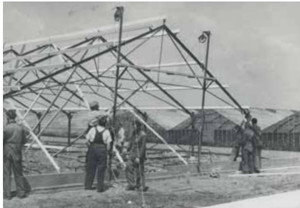
Westland, foto van het oprichten van een kas, opname gemaakt vóór de Tweede Wereldoorlog, no. 329-3-10 Westlands Museum in Honselersdijk. Hier is de firma J. Duijnsveld aan het werk. Men past hier polonceauspanten toe voor de draagconstructie.
