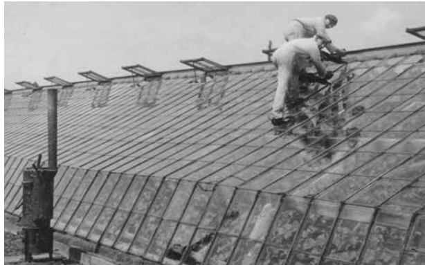
Twee broers Zeeman aan het kassenkitten in 1948. Linksonder een kitketel waarin het kit vloeibaar werd gemaakt. Deze kitkachels werden voor deze firma door smid W. Bloemendaal uit Monster gemaakt. De kachels werden eerst gestookt met hout (vaak met restanten van raaml ijsten), daarna met gasolie en later met butagas, foto Collectie dhr. Zeeman te Monster.
