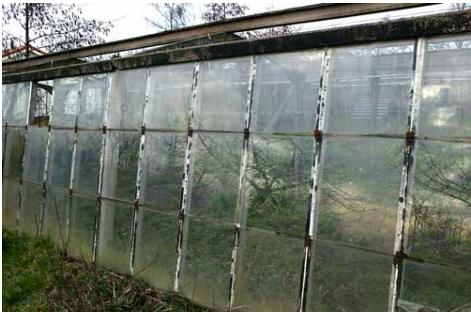
Glasbevestiging door middel van een ijzeren plaatje in een kas uit 1916, foto Jack van Bodegom, Den Haag/Spijkenisse.
