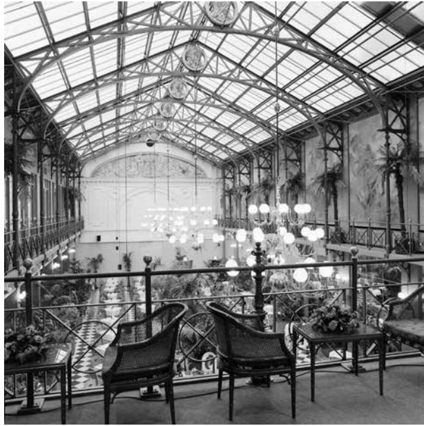
Amsterdam, dakconstructie in de wintertuin (1879) van hotel Krasnapolsky, foto G.J. Dukker 1992, no. 298.615 Collectie RCE. Er zijn hier 'vakwerkspanten met bovenrand in driehoekige vorm en opwaarts gebogen onderrand' toegepast.
