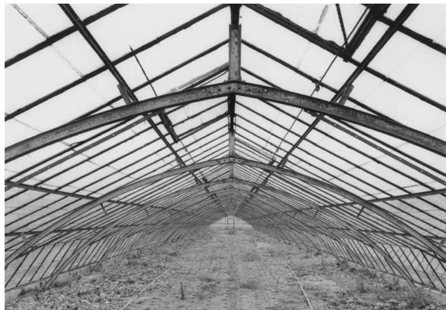
Heenweg, boogspanten in een van de gesloopte druivenkassen die in de jaren 20 van de vorige eeuw zijn gebouwd, foto J.P. de Koning 1999, no. 327.823 Collectie RCE.
