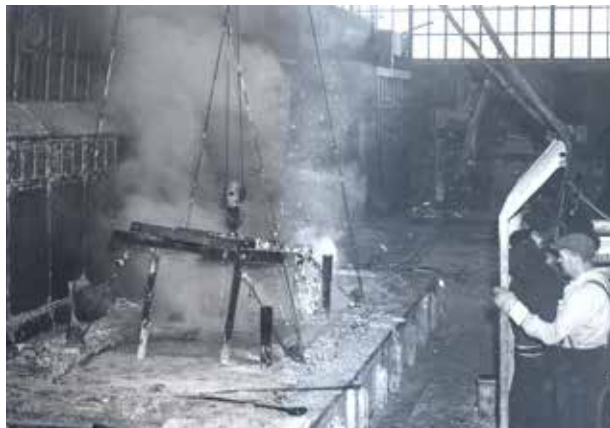
Amsterdam, verzinkerij van Johan Vis aan de Distelweg, foto zinkbad eind jaren vijftig - begin jaren zestig, maker onbekend, archief NedCoat Amsterdam.
