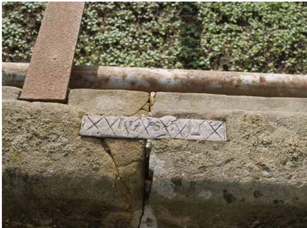
Markelo, kasteel Weldam, loden kram in een rand van een van de zandstenen bakken, foto IJ.Th. Heins 2005, no. 513.798 Collectie RCE.
