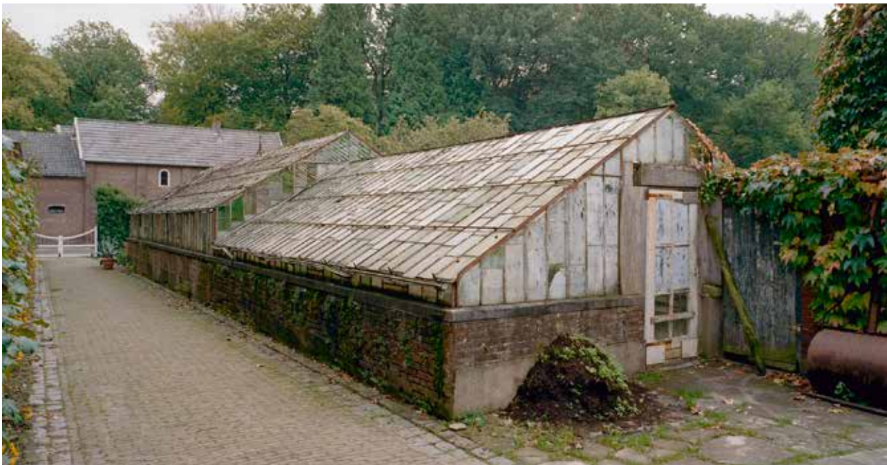
Geldrop, kasteel Geldrop, foto van de achterzijde van de tabletkas (1885), foto J.P. de Koning 2001, no. 338.821 Collectie RCE. In de kas zit op enkele plekken nog groen oud glas.
