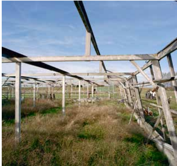
Heenweg, Maasdijk 19, eenvoudige constructie van een houten warenhuis, foto J.P. de Koning 2001, no. 333.416 Collectie RCE.
