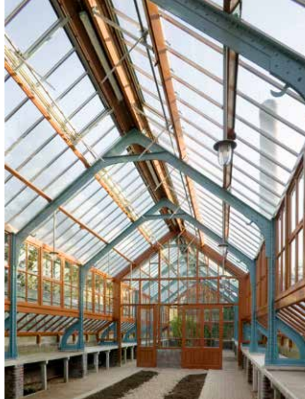
Utrecht, de Oude Hortus Botanicus, draagconstructie van het hoge gedeelte van de Collectiekas na restauratie, foto C.S. Booms 2006, no. 516.453 Collectie RCE.
