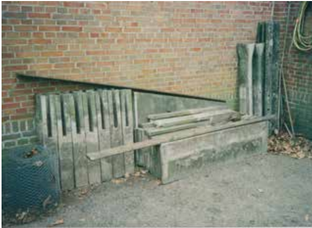
Betonnen bakken laten zich uitstekend demonteren en opslaan, zoals hier in Enschede op de buitenplaats Zonnebeek, foto B.H.J.N. Kooij 2003, Collectie RCE.
