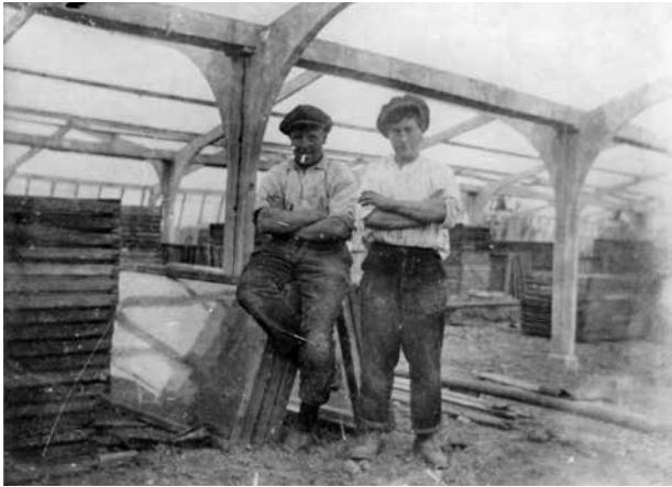
Wateringen, tuinderij van Frans van den Berg aan de Sweeruslaan, betonnen warenhuizen in aanbouw in 1922, fotograaf onbekend, no. 353-3-10 Collectie Westlands Museum Honselersdijk.
