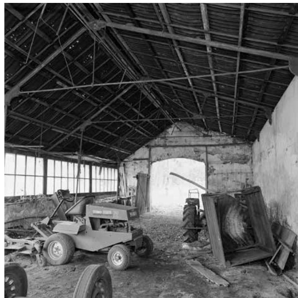
Hattem, Huis Molecaten, polonceauspanten in de oranjeriekas vóór de restauratie, foto A.J. van der Wal 1992, no. 292.916 Collectie RCE.
