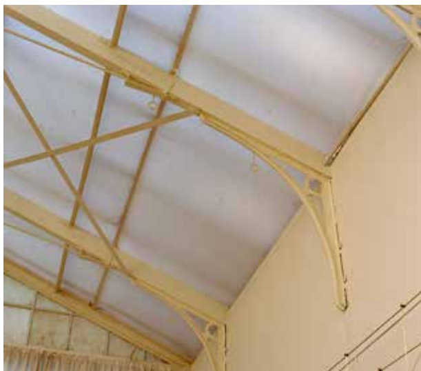
Baarn, Cantonspark, eenvoudig windverband in het dak van de wintertuin, foto IJ.Th. Heins 2002, no. 341.651 Collectie RCE.
