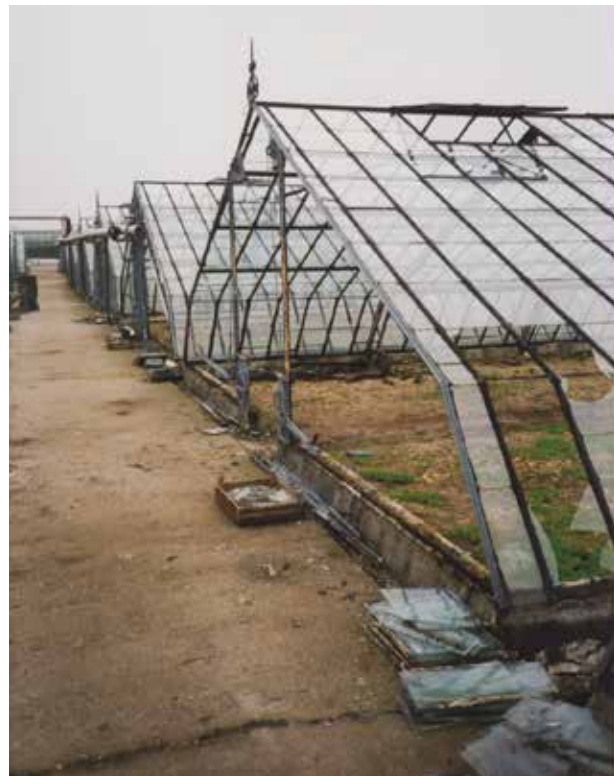
Monster, bij Assendelftlaan 8, druivenkassen met bitumenkit gedicht, foto B.H.J.N. Kooij 1999, Collectie RCE. Opname tijdens de sloop gemaakt.
