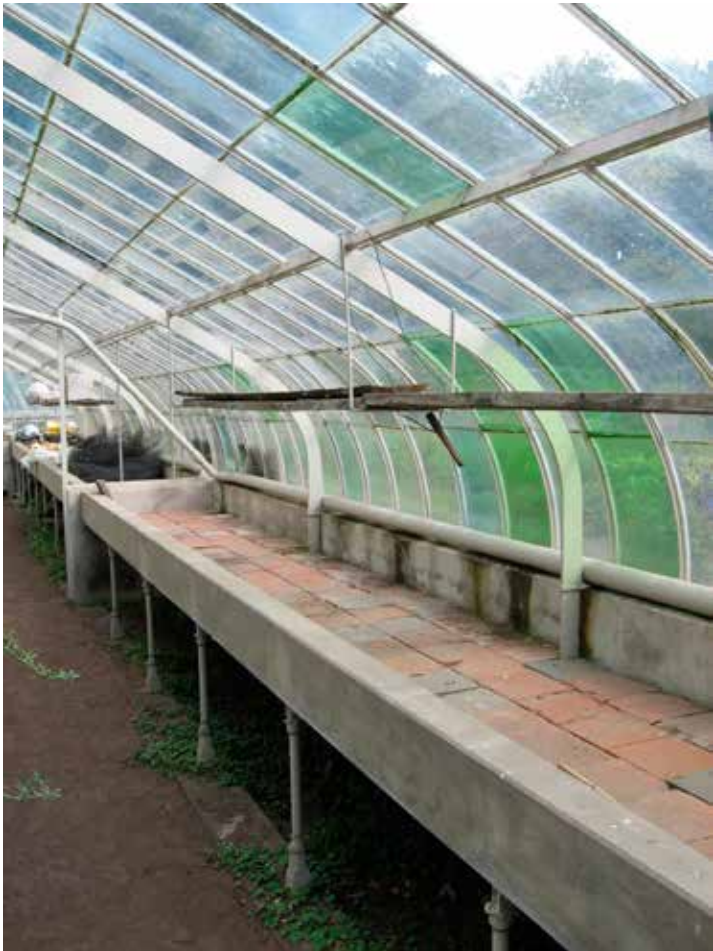
De Bilt, Vollenhoven, volwandige kniespanten in de tabletkas, foto B.H.J.N. Kooij 2006, Collectie RCE.
