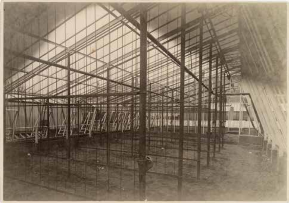
Schoonheeten, buitenplaats Schoonheeten, interieur van een bijzondere ijzeren kas: een zogenoemde zadelkas, Collectie D.M. Servaas, Gemeentearchief Zeist, repro no. 505.843 Collectie RCE. De kas is gebouwd door de firma Gadellaa uit Zeist omstreeks 1920. Voor de bouw is profielijzer toegepast.
