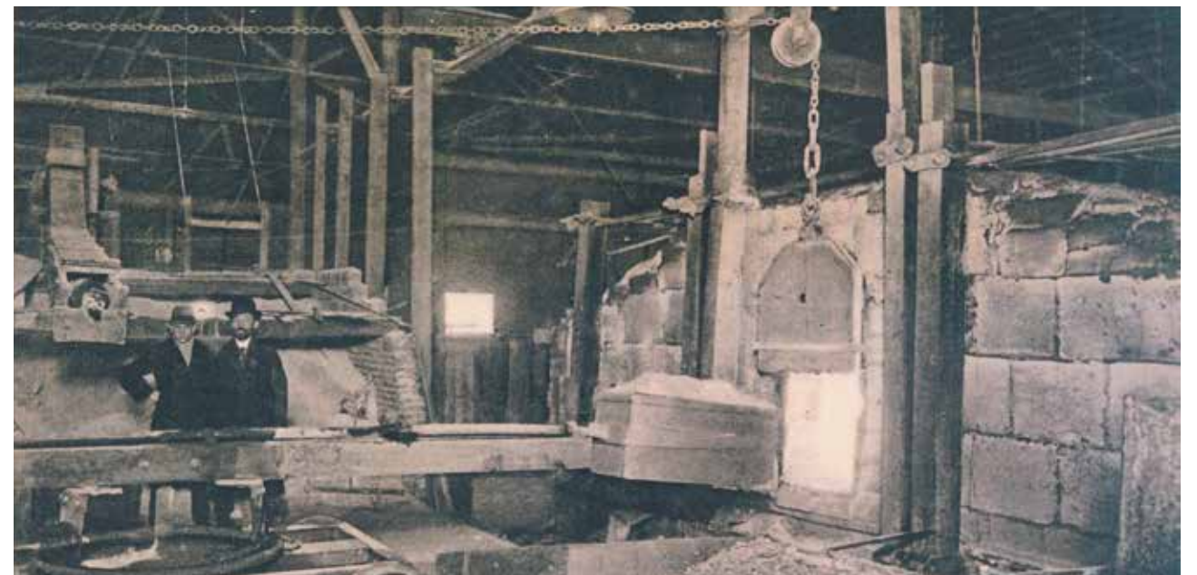
Maassluis, het aanbrengen van een lading grondstoffen in de glasoven van de Eerste Hollandsche Vensterglasfabriek Maassluis, Collectie Gemeente Museum Maassluis.
