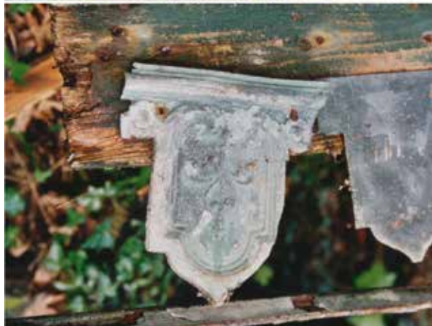
Vught, Taalstraat 149, landgoed Zionsburg, zinken gootje aan de kas en zinken versiering aan de kas. Foto's B.H.J.N. Kooij 2005, Collectie RCE.
