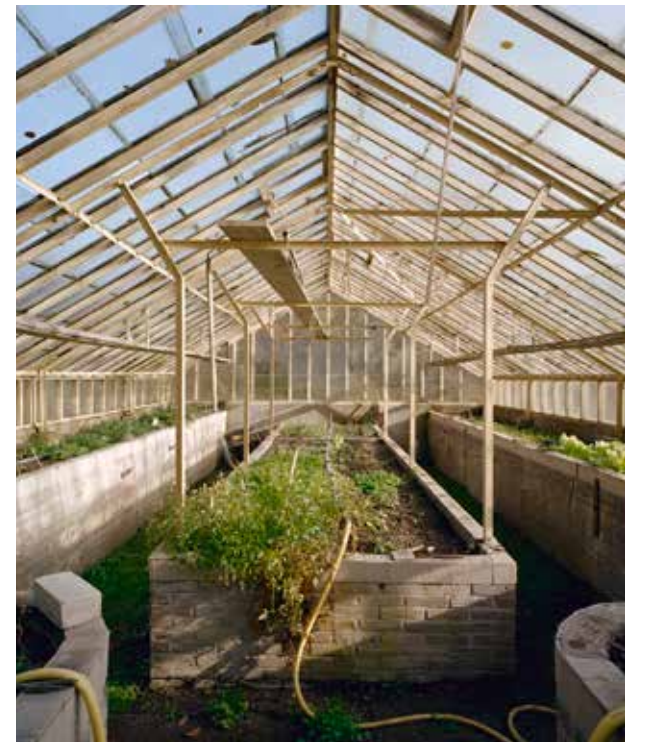
Empe, huis Empe, interieur tabletkas met zicht op de ijzeren draagconstructie en de houten glasroeden, foto J.P. de Koning, 2001, no. 338.759 Collectie RCE.
