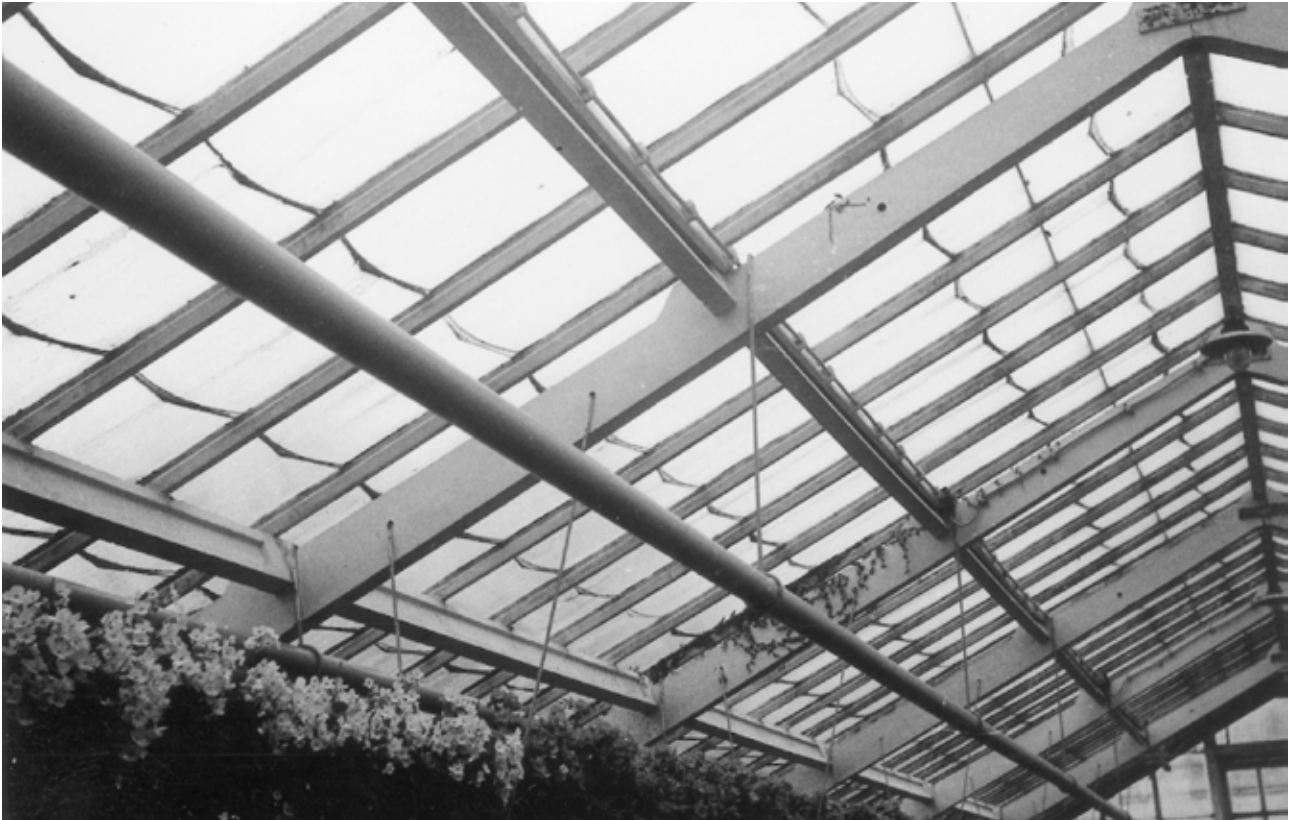
Foto uit 1966 van het interieur van een kas met duidelijk zicht op de glasruiten die aan de bovenzijde rond en aan de onderzijde puntig zijn afgesneden, foto no. 497E uit het archief van het voormalig Proefstation te Naaldwijk.
