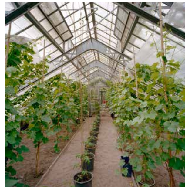
Ermelo, Oud-Groevenbeek, interieur druivenkas na restauratie met zicht op de vakwerkspanten, foto J.P. de Koning 2001, no. 343.235 Collectie RCE.
