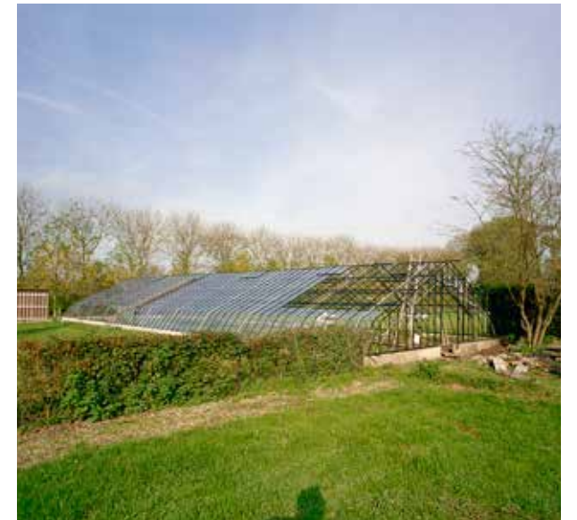
Langbroek, kasteel Hindersteyn, Westlandse druivenserre tijdens de heropbouw in de moestuin, foto J.P. de Koning 2001, no. 338.650 Collectie RCE.
