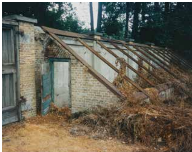
Lisse, kasteel de Keukenhof, moestuin, het houtwerk van de muurkas- sen is hier op ongebruikelijke wijze vervangen door ijzerwerk, foto B.H.J.N. Kooij 2003, Collectie RCE. Deze speciale ijzerconstructie maakt het de tuinbaas mogelijk meerdere ramen tegelijk open te zetten.
