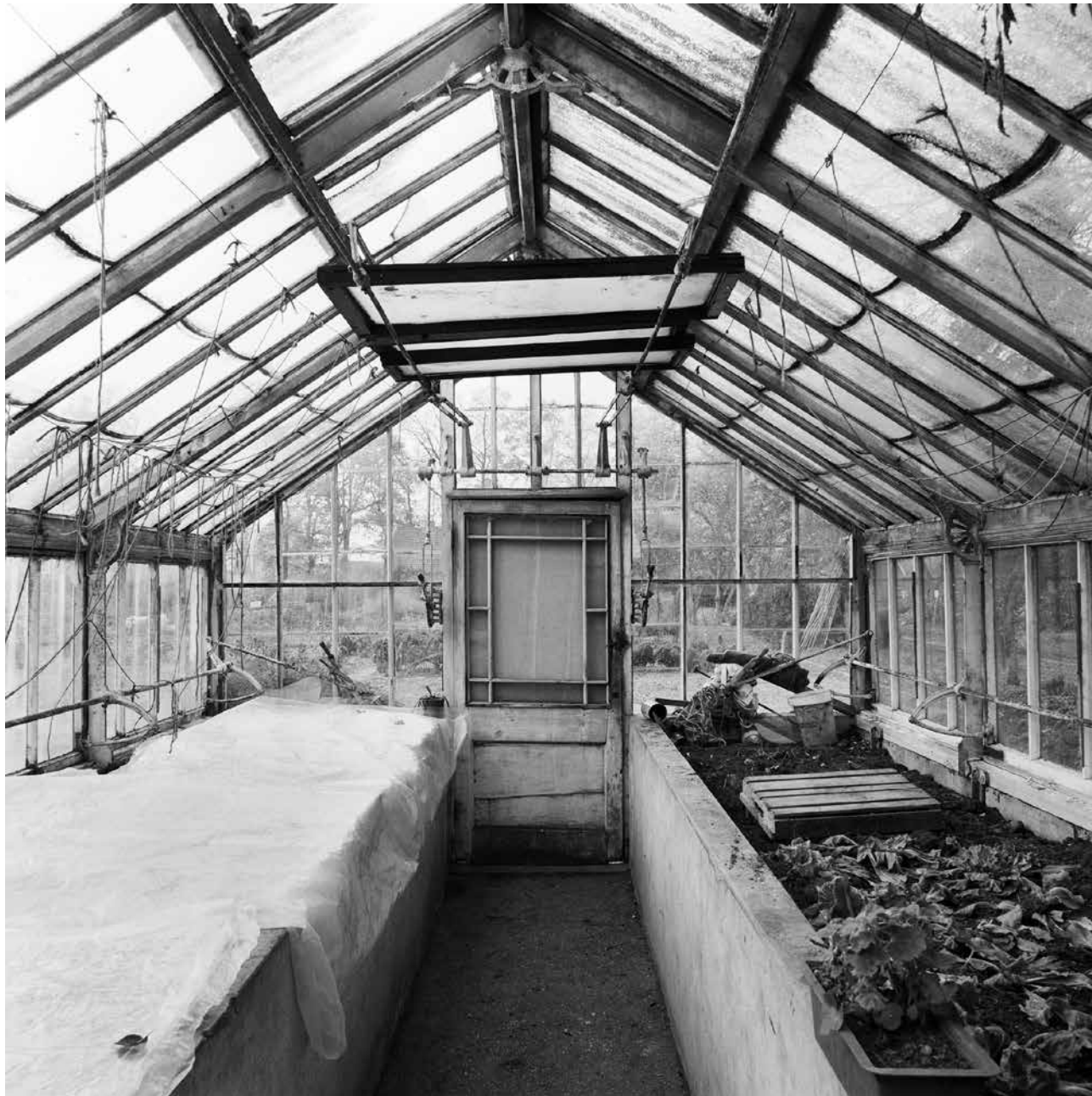
Ambt Delden, Kasteel Twickel, interieur anjerkas vóór de restauratie, foto A.J. van der Wal 1985, no. 292.677 Collectie RCE. Vóór de restauratie zaten er -zoals op deze foto is te zien- rond afgesneden ruiten in het dek.
