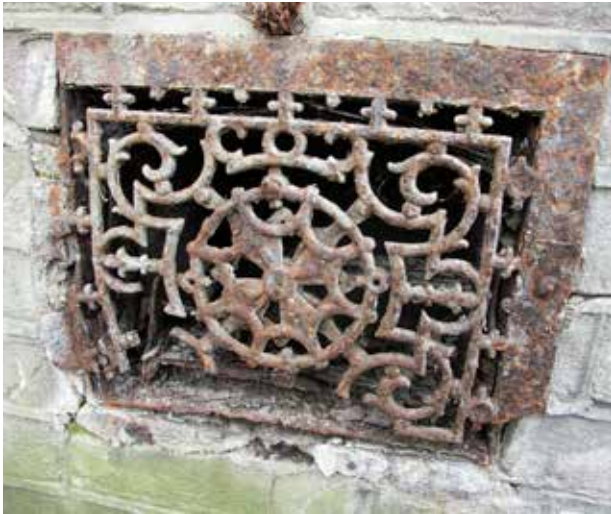
Utrecht, de Oude Hortus Botanicus, het vochtige milieu in de kas veroorzaakt ernstige roestvorming en vraagt een goede conservering van ijzeren onderdelen, foto M. van Hunen 2005, Collectie RCE.
