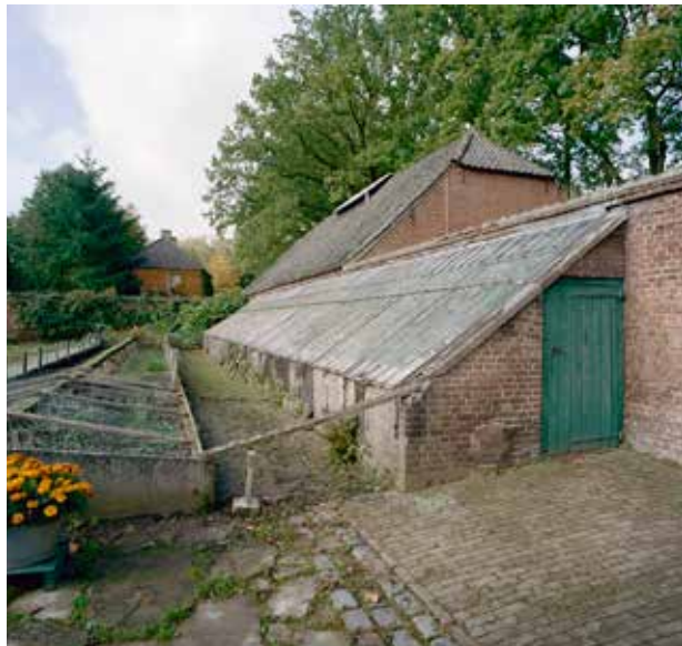
Geldrop, kasteeltuon, muurkas met vernieuwd dek, foto J.P. de Koning 2001, no. 338.818 Collectie RCE. Hoewel het dek niet op de originele wijze is vernieuwd, heeft hij toch zijn functie behouden.
