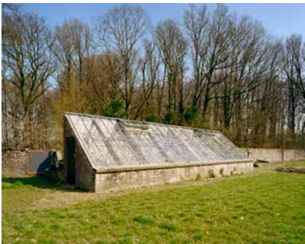
Eefde, buitenplaats 't Klaphek, muurkas type lessenaar, foto IJ.Th. Heins 2002, no. 342.327 Collectie RCE. Door het ijzeren glasdek -een latere vernieuwing- is de oude structuur te zien: een muurkas met kasramen.
