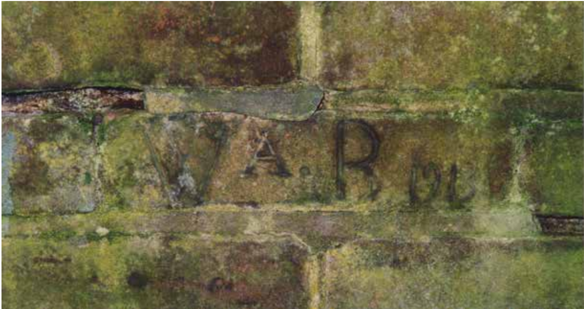
Ellecom, buitenplaats Hofstetten, Zutphensestraatweg 70, jaartalsteen met de aanduiding 'W. A. B. 1913' in de onderbouw van de houten kas, foto B.H.J.N. Kooij 2002, Collectie RCE. Door grondig onderzoek kunnen dergelijke jaartalstenen ontdekt worden.
