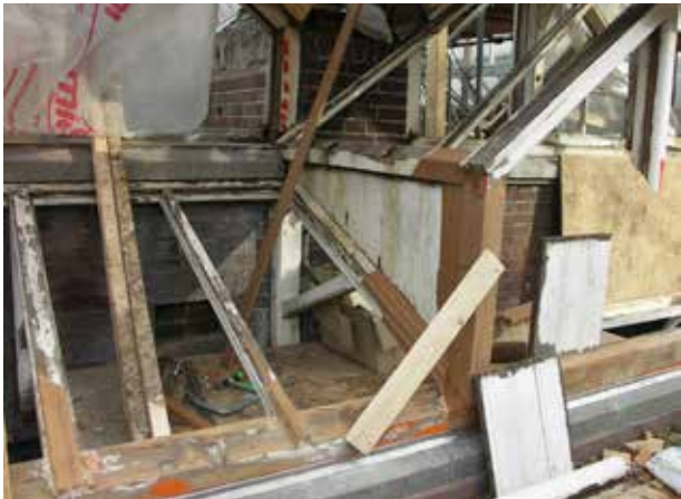
Utrecht, de Oude Hortus Botanicus, tijdens de restauratie worden aangetaste delen van de houtconstructie vervangen door nieuw teakhout, foto M. van Hunen 2005, Collectie RCE. Teakhout heeft een zeer hoge natuurlijke duurzaamheid (duurzaamheidsklasse 1).
