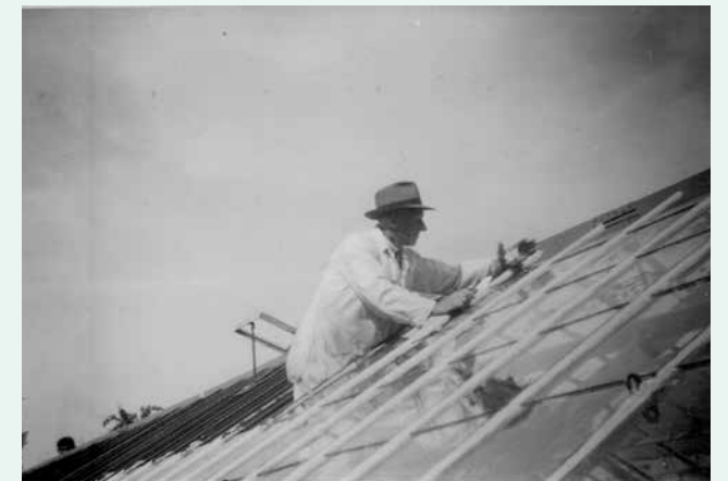
Jacob Graafland bezig met het beglazen van kassen ca. 1935, foto Collectie G. Tilstra-Graafland.
