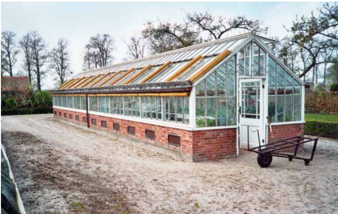
Ambt Delden, Kasteel Twickel, in de moestuin gelegen houten anjerkas na restauratie, foto B.H.J.N. Kooij 2002, Collectie RCE. Bij de restauratie is het luchtwerk hersteld en zijn nieuwe scherm-latten weer teruggekomen. Om het wegglijden van scherm-latten te voorkomen dient er -zoals hier- een plank onderaan haaks op het dek bevestigd te worden.
