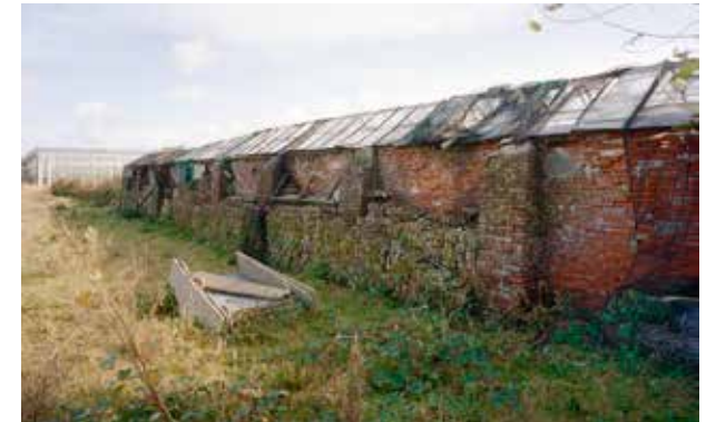
Monster, Hoogwerf 80, metselwerk (halfsteens verband) van de ijzeren kopkas (1899) in slechte conditie, foto J.P. de Koning 2000, no. 338.863 Collectie RCE. De kas is inmiddels gedemonteerd en gerestaureerd, maar op een andere locatie in Monster opgebouwd.
