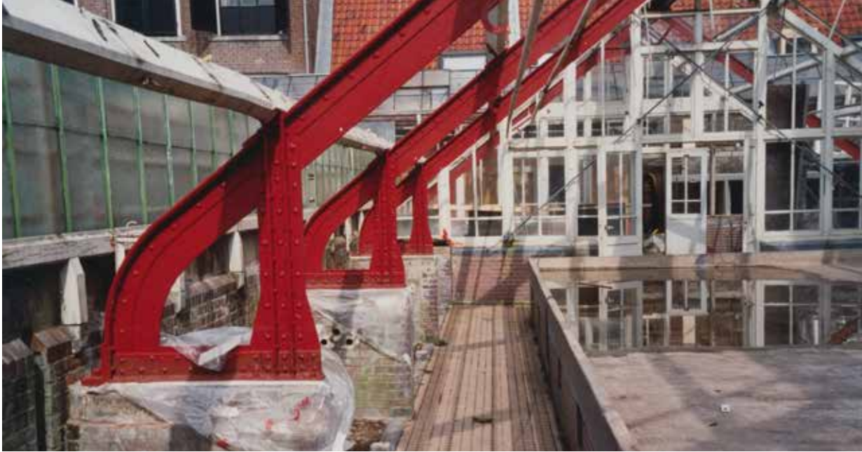
Utrecht, de Oude Hortus Botanicus, collectiekas, de samengestelde spanten van de kas hebben na een reiniging een conserverende behandeling gehad, foto B.H.J.N. Kooij 2005, Collectie RCE. De rode kleur is tijdelijk geweest. Door kleuronderzoek is komen vast te staan dat de spanten oorspronkelijk blauw waren. Na de restauratie hebben de spanten deze kleur weer teruggekregen.
