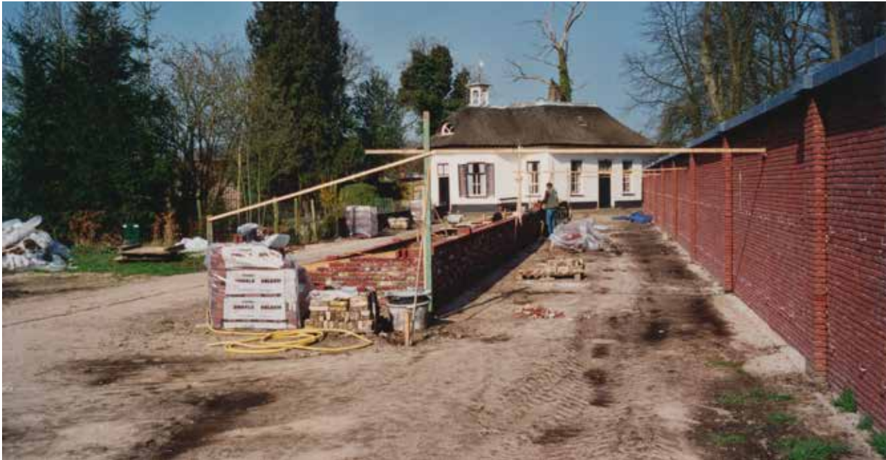
Leusden, buitenplaats Heiligenberg, restauratie van de bakken en de fruitmuur in de moestuin, foto B.H.J.N. Kooij 2005, Collectie RCE. De fruitmuur, voorheen in beton maar oorspronkelijk in baksteen, is bij de laatste restauratie opnieuw in baksteen opgetrokken. Op de achtergrond is de tuinderswoning te zien.
