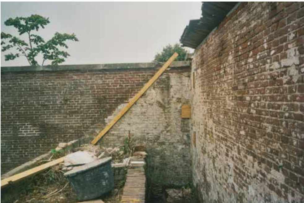
Amerongen, kasteel Amerongen, bouwhistorisch onderzoek van de muurkassen. De afbeelding geeft de helling van de eerste kas (fase 1) aan, foto B.H.J.N. Kooij 2003, Collectie RCE.
