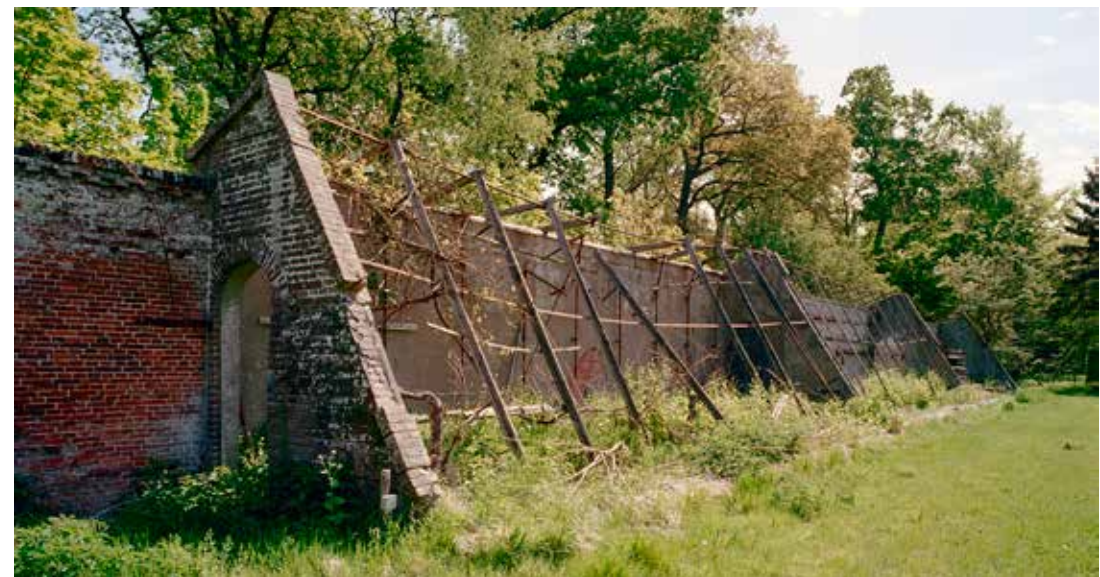
Vogelenzang, buitenplaats Vogelenzang, houten kopkas in de moestuin vanaf links gezien, foto IJ.Th. Heins 2003, no. 346.207 Collectie RCE.
