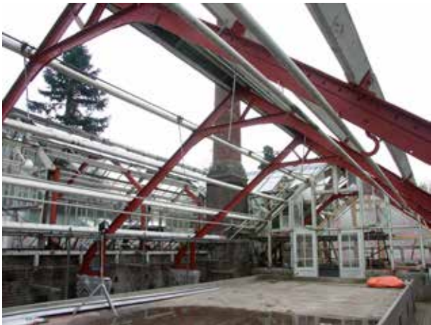
Utrecht, de Oude Hortus Botanicus, draagconstructie die is opgebouwd uit samengestelde stalen spanten en houten gordingen, foto M. van Hunen 2005, Collectie RCE.
