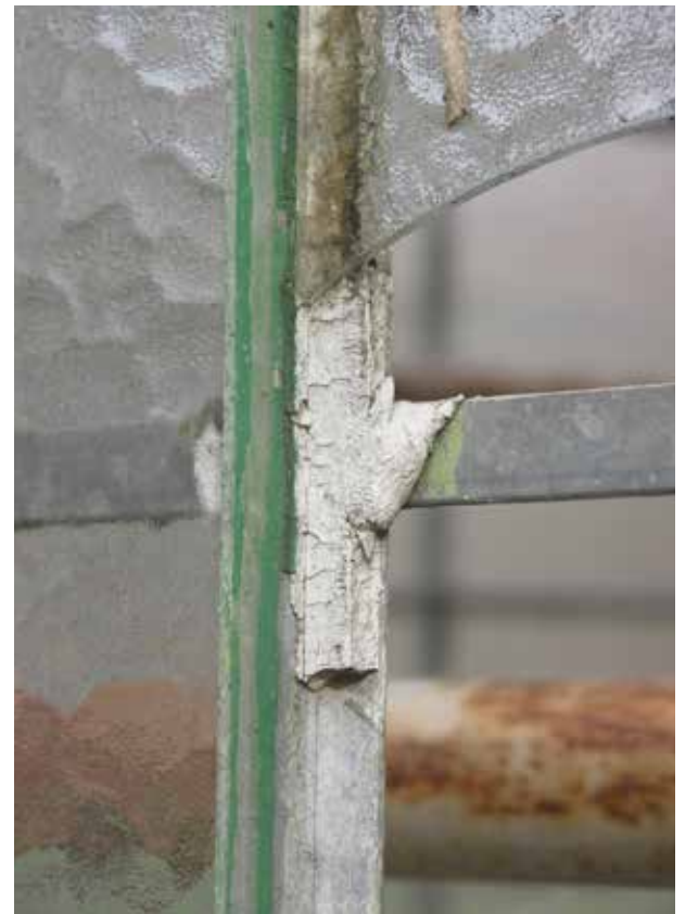
Utrecht, de Oude Hortus Botanicus, verouderde stopverf, foto M. van Hunen 2005, Collectie RCE. Door veroudering wordt de stopverf hard, broos en krimpt het. Glas kan daardoor los in de sponning komen te liggen.
