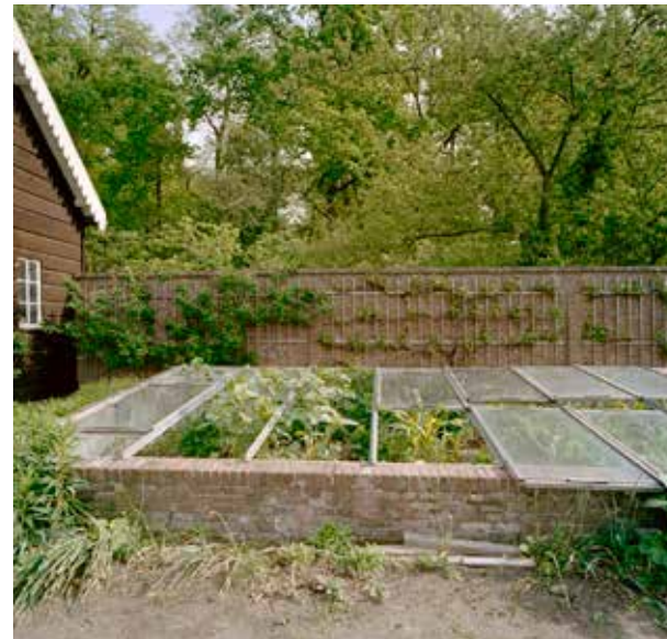
Alternatieve functie: Warmond, Oostergeest, alternatief gebruik van brede broeibak met ijzeren liggers en twee éénruiters in de breedte, foto IJ.Th. Heins 2003, no. 346.126 Collectie RCE.
