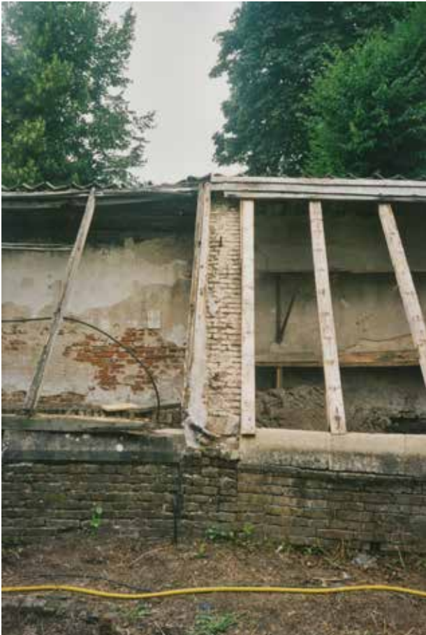
Amerongen, kasteel Amerongen, bouwhistorisch onderzoek van de muurkassen: duidelijk is waar te nemen dat het rechterdeel van de muurkas later is aangebouwd, foto B.H.J.N. Kooij 2003, Collectie RCE.
