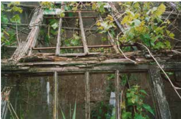
Nieuwersluis, buitenplaats Middenhoek, muurkas van het type gebroken lessenaar, foto B.H.J.N. Kooij 2004, Collectie RCE. Deze foto maakt duidelijk dat het bovendakvlak is opgebouwd uit losse ramen en het onderdakvlak vast glas heeft.
