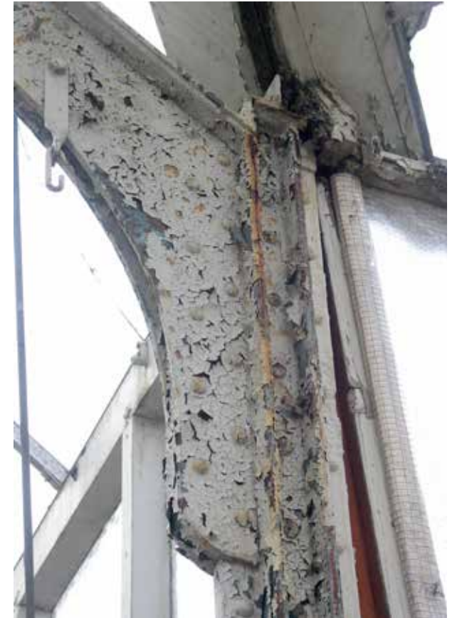
Utrecht, de Oude Hortus Botanicus, vóór restauratie, foto M. van Hunen 2005, Collectie RCE. Onder de loskomende sterk verouderde witte verflagen komt de oorspronkelijke blauwe kleur tevoorschijn.
