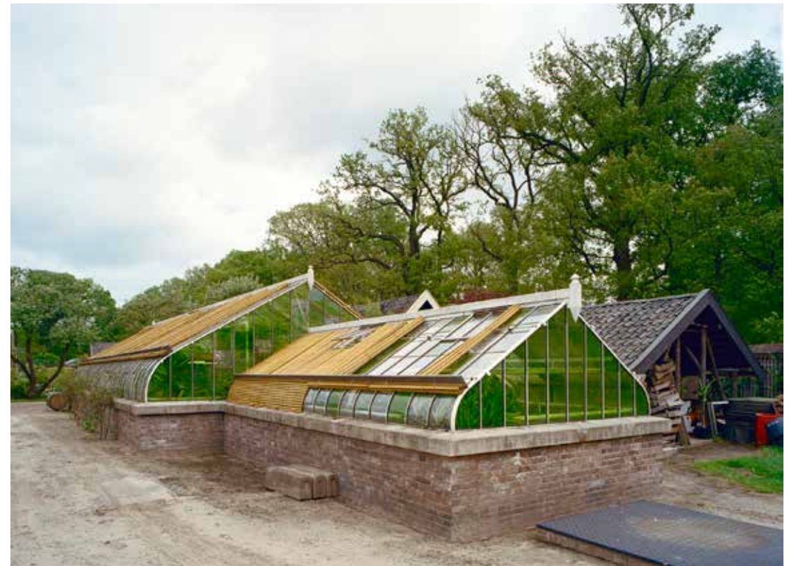
Ambt Delden, Kasteel Twickel, ijzeren tabletkas ná de restauratie, foto IJ.Th. Heins 2002, no. 343.069 Collectie RCE. Hoewel de kas veel achterstallig onderhoud had, was hij toch te restaureren. Nieuwe schermalatten completeren de restauratie op voorbeeldige wijze.
