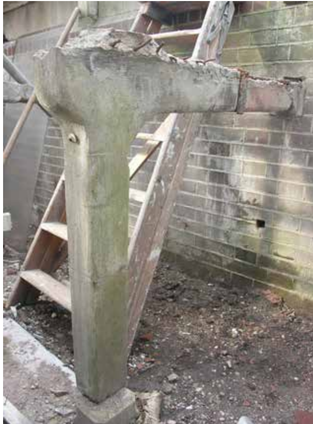
Utrecht, de Oude Hortus Botanicus. De prefab betonnen tabletdrager verkeert, op de gescheurde oplegging na, nog in goede staat, foto M. van Hunen 2005, Collectie RCE.
