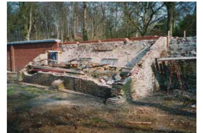
Leusden, buitenplaats Heiligenberg, restauratie van de muurkas in de moestuin, foto B.H.J.N. Kooij 2005, Collectie RCE.
