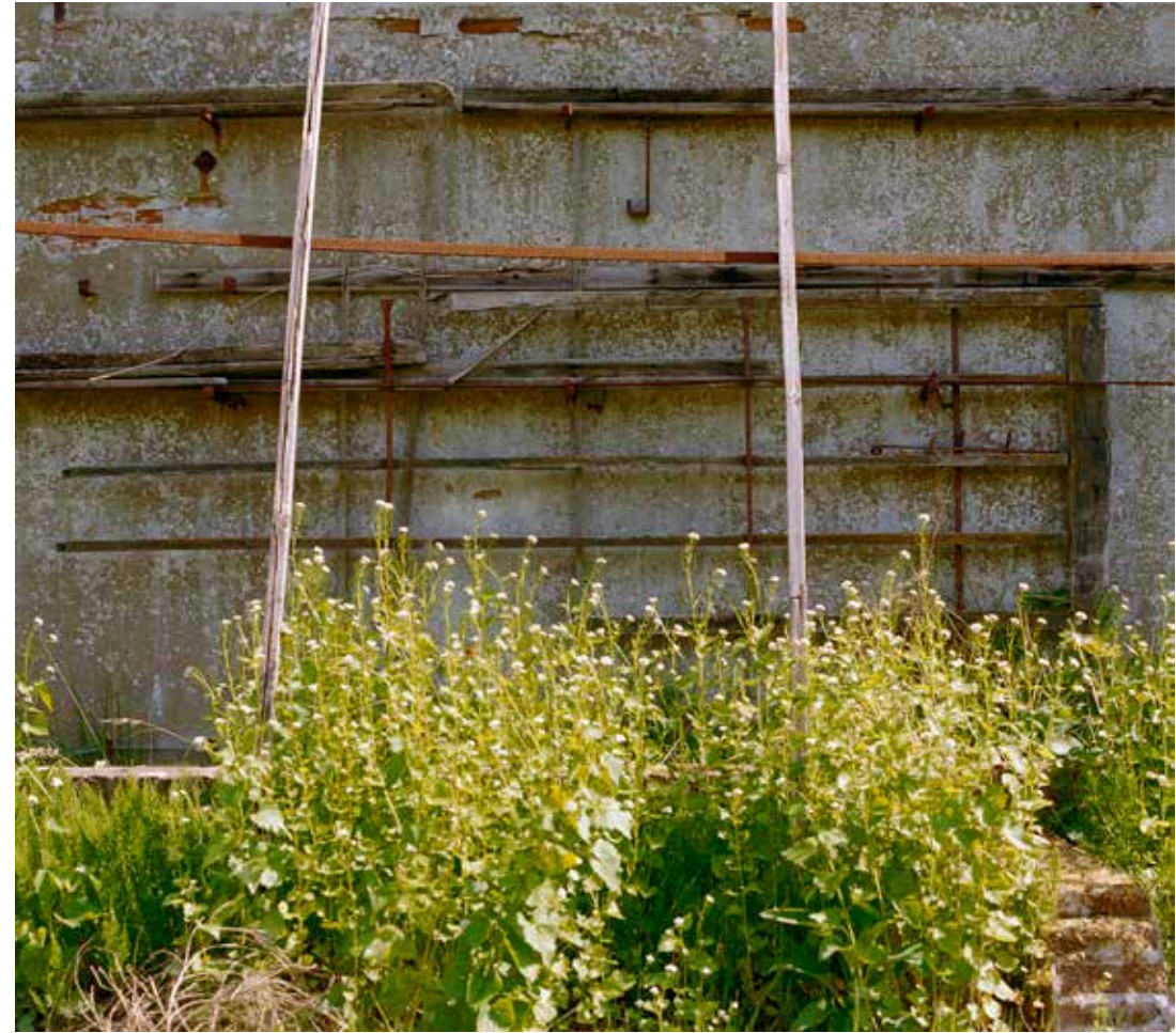
Vogelenzang, buitenplaats Vogelenzang, klein deel van de houten kopkas in de moestuin met tegen de muur een van de houten ramen die op het dek hebben gelegen, foto IJ.Th. Heins 2003, no. 346.212 Collectie RCE. Het houtwerk is grotendeels verdwenen en wat er rest is verrot, zodat restauratie van het houten dek niet meer mogelijk is.
