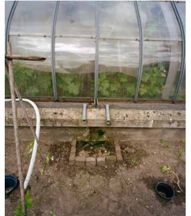
Ermelo, Oud-Groevenbeek, detail druivenkas na restauratie, foto J.P. de Koning 2001, no. 343.234 Collectie RCE. De restauratie is onder toezicht van de eigenaar, Natuurmonumenten, uitgevoerd. Om een zo'n onderhoudsarme mogelijke kas te krijgen heeft men speciale gestante zinken afdekstrip gemaakt om het onderhoud van stopverf te vermijden. Deze reversibele oplossing is uniek. Ook aan de vochttafvoer is veel aandacht besteed.
