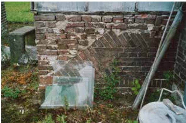
Maartensdijk, buitenplaats Eyckenstein, detail van het metselwerk van de onderbouw van de orchideeënkas waar duidelijk de verandering van de stookruimte is waar te nemen, foto B.H.J.N. Kooij 2005, Collectie RCE. Vóór de wijziging stond de ketel in een verdiepte ruimte in de grond.
